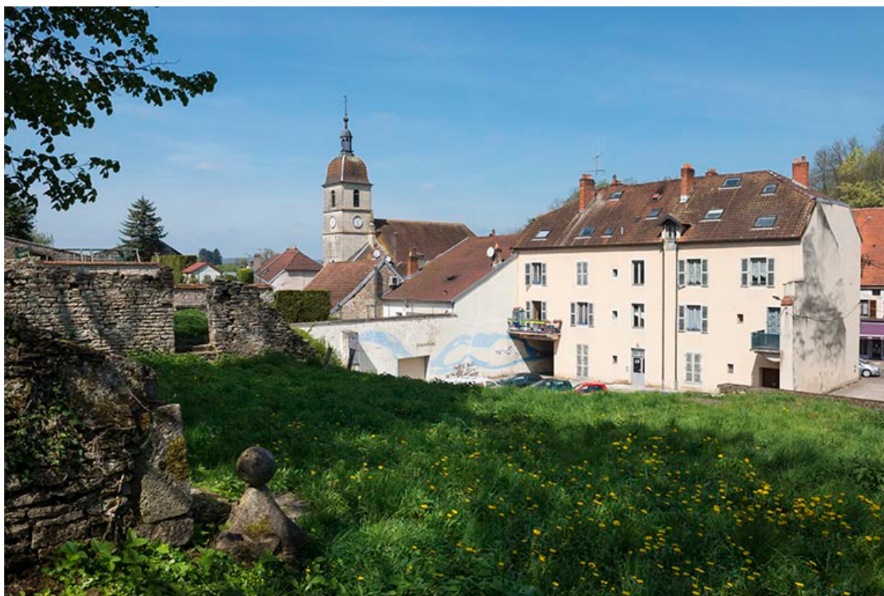
L'mmeuble Madiot, façade postérieure.
