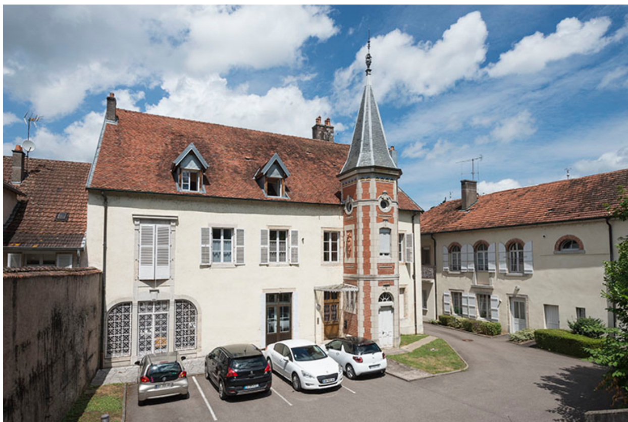
Façade postérieure de la demeure.
