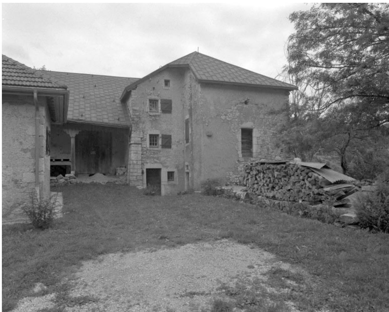
Façade sud-est, partie gauche du bâtiment.
