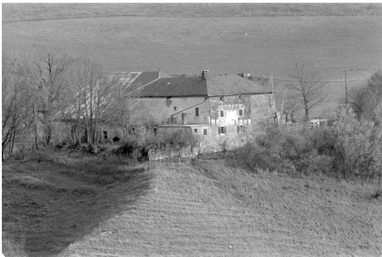
Vue rapprochée de la façade nord-ouest.
