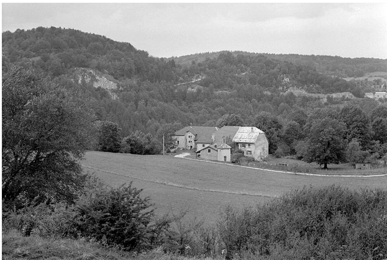
Vue générale, façade sud-est.
