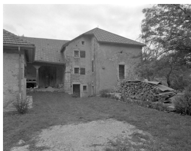
Façade sud-est, partie gauche du bâtiment. Phot. Jérôme Mongreville IVR43_19943900846X
