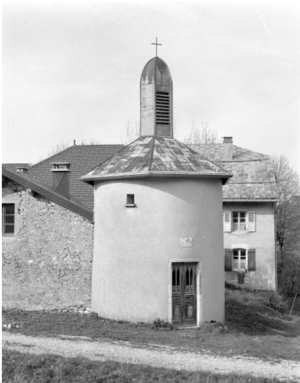
Tour transformée en oratoire.
