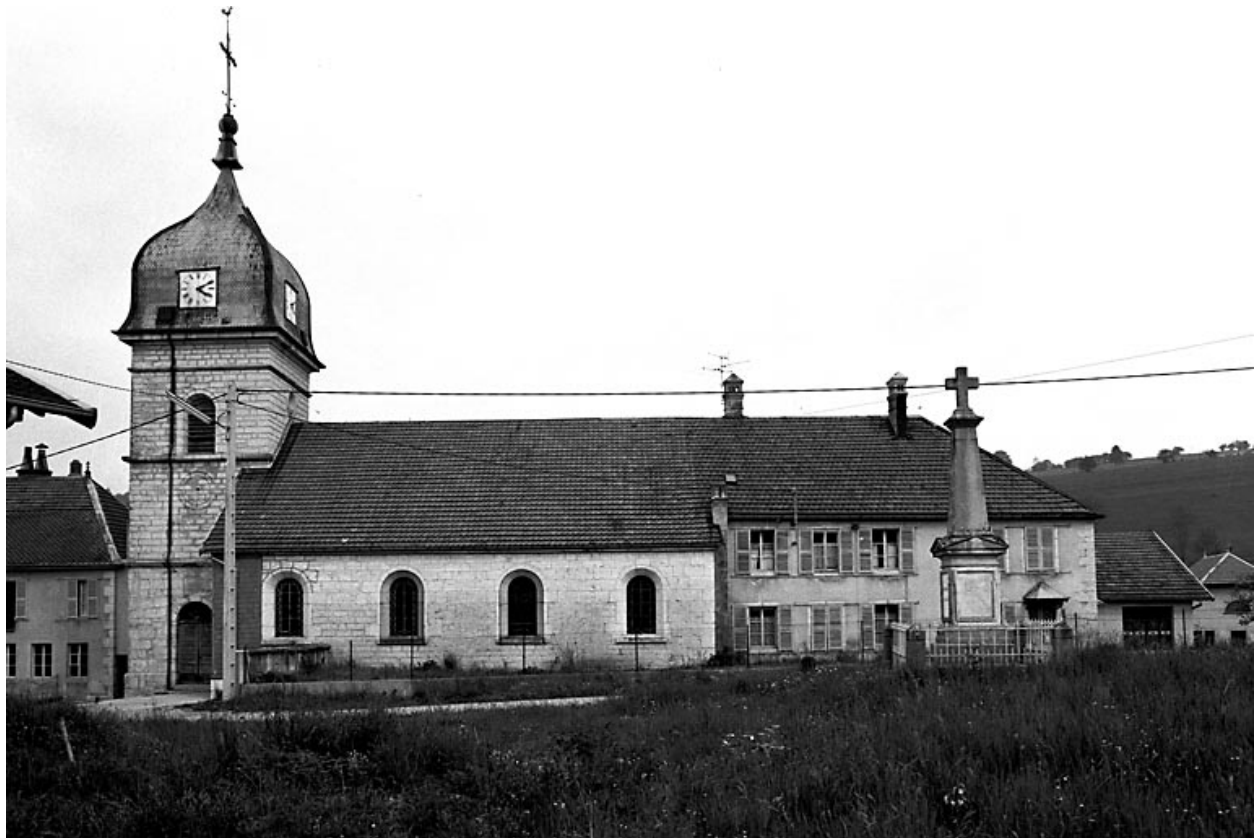
Façade latérale droite.
