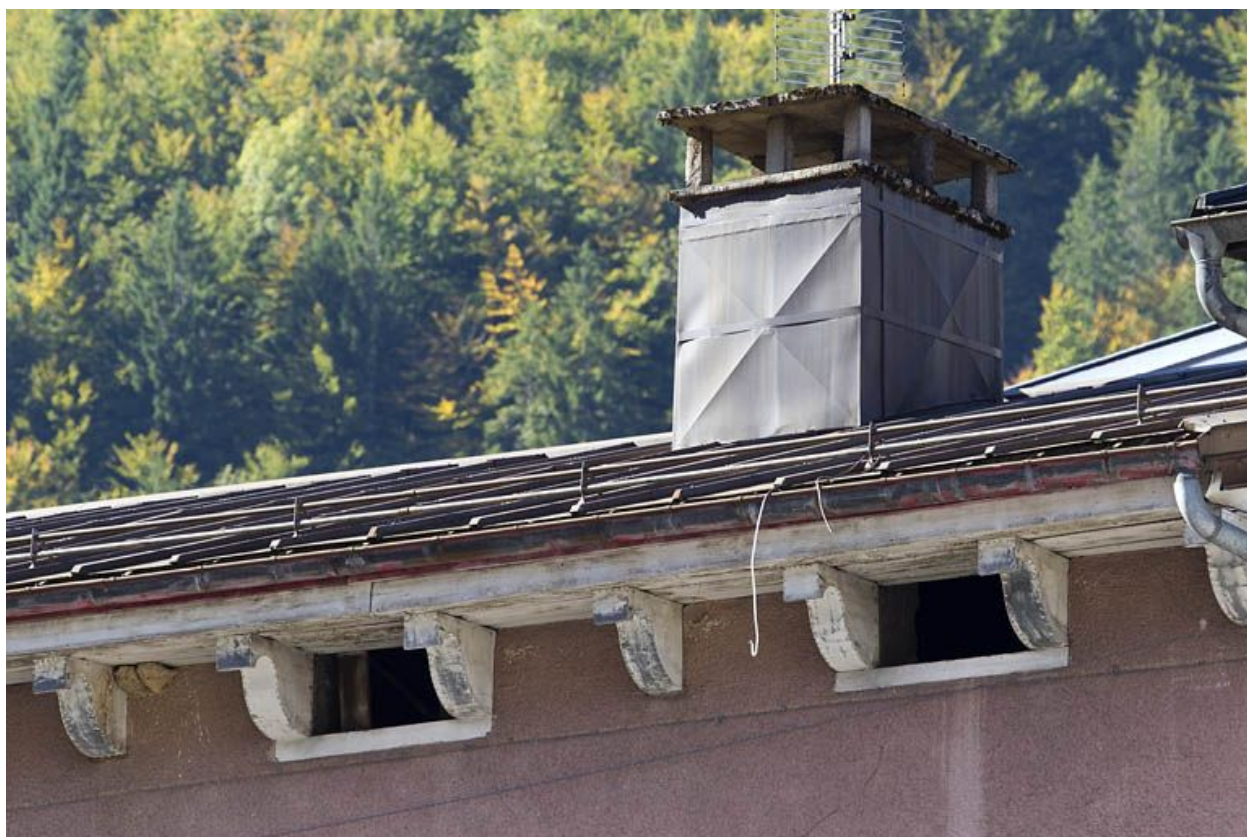
Corniche et ses corbeaux.
