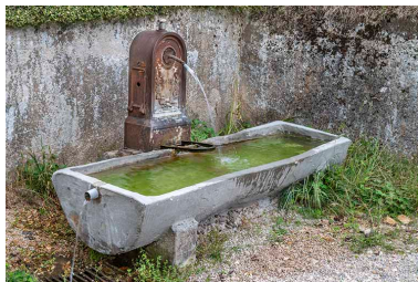
Borne-fontaine et abreuvoir Phot. Jérôme Mongreville IVR43_20233900651NUC4A
