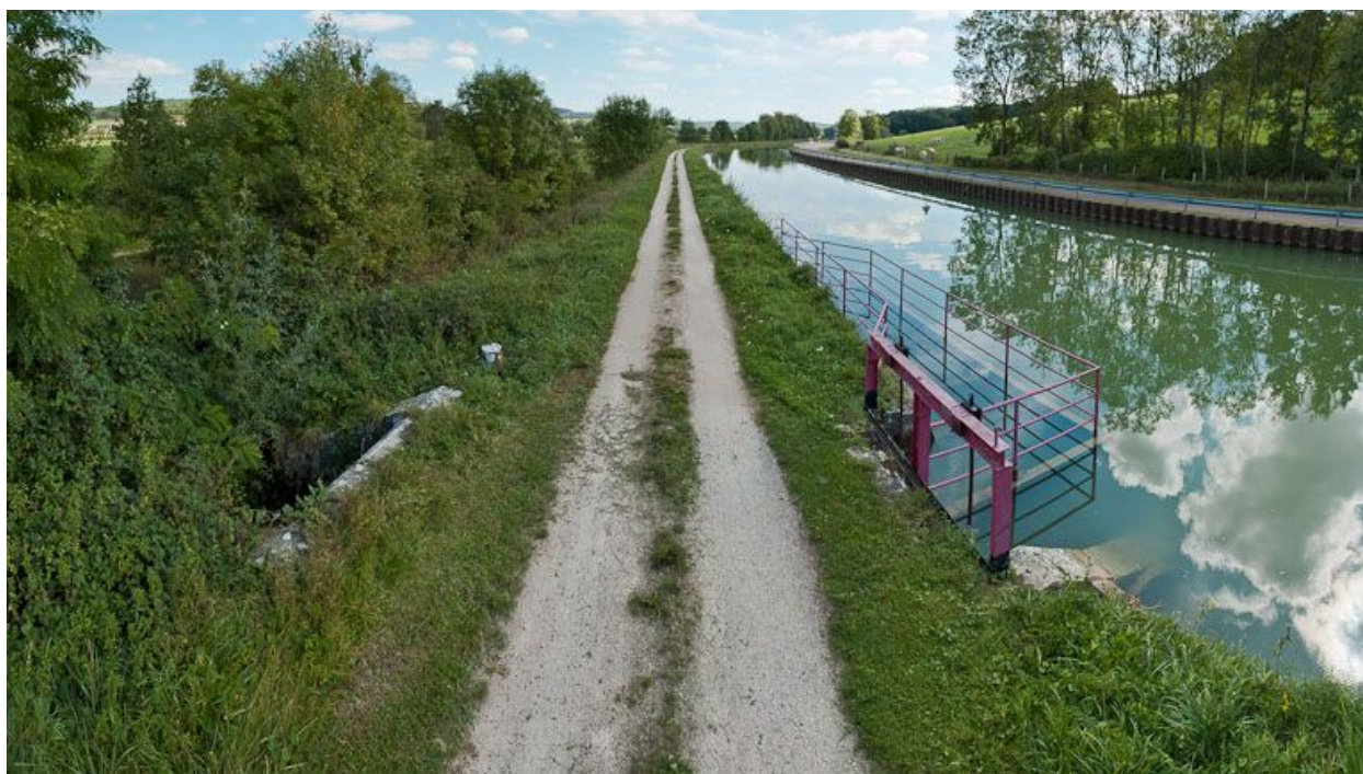
Vue du déversoir.
