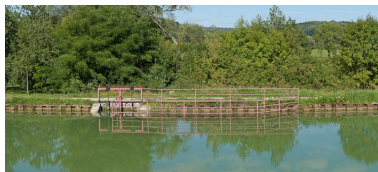
Vue du déversoir depuis la rive opposée. Phot. Pierre-Marie Barbe-Richaud IVR26_20112104150NUC4AQ
