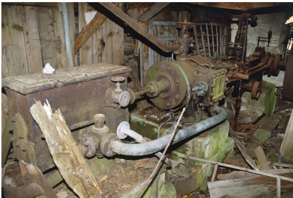
Vue d'ensemble de la machine à vapeur.
