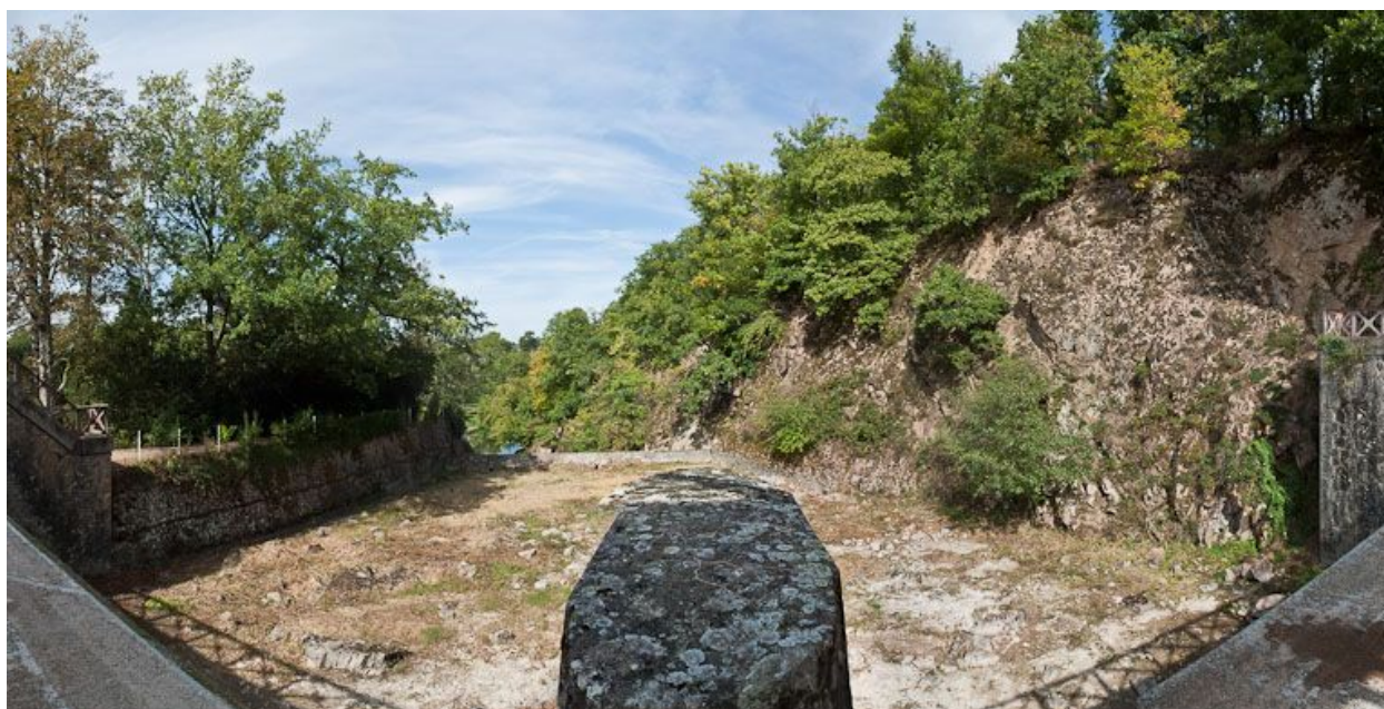
Vue de la rigole de décharge du déversoir.
