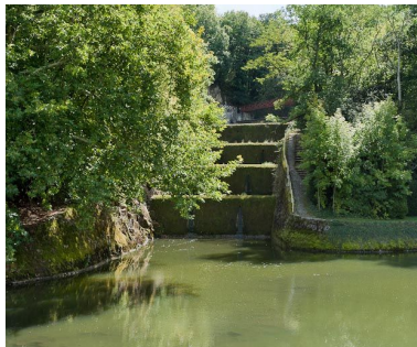
Vue d'ensemble depuis le parc. Phot. Pierre-Marie Barbe-Richaud IVR26_20112103652NUC4AQ
