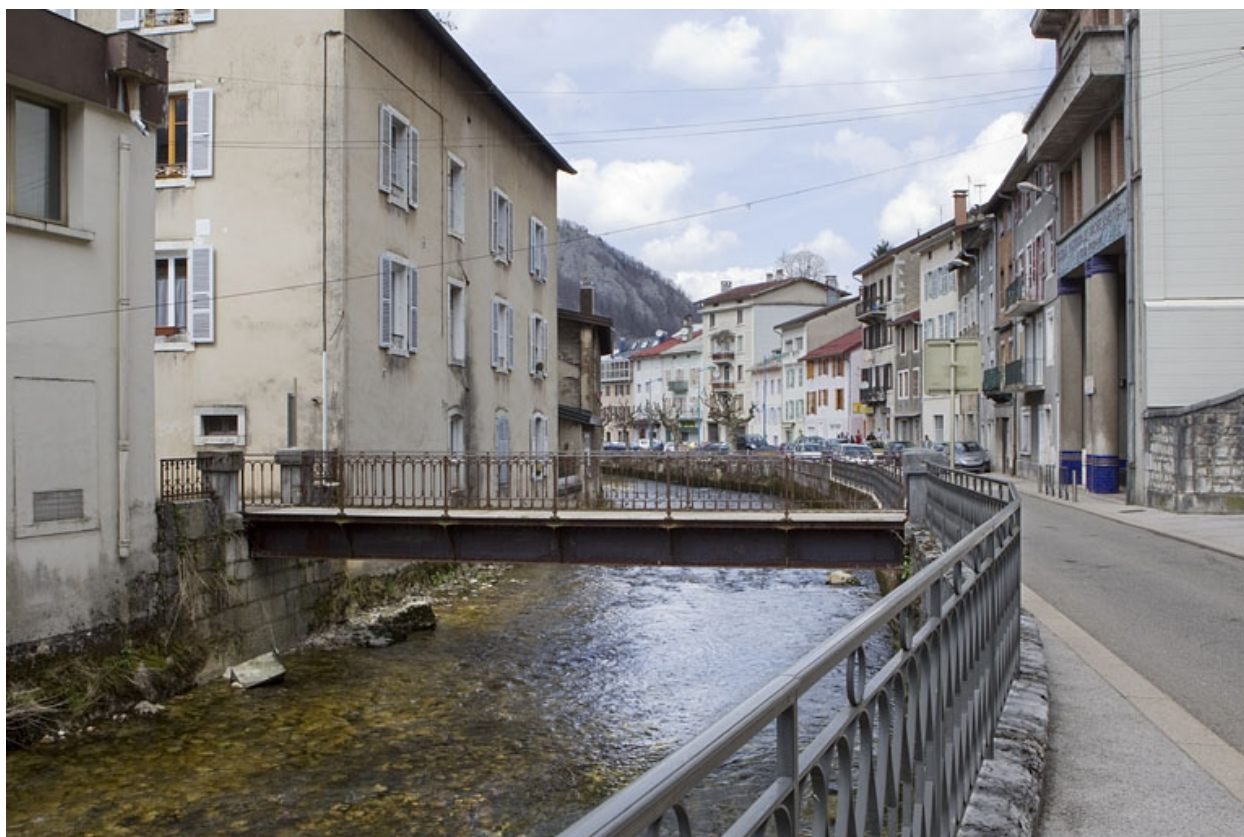
Vue d'ensemble, depuis l'amont.
