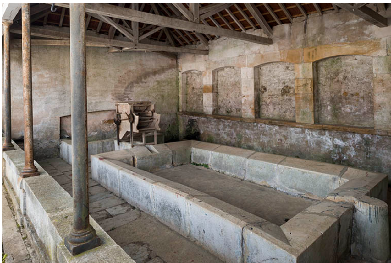
Vue intérieure de l'édifice.
