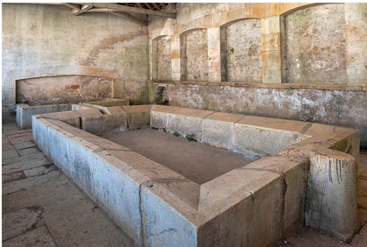
Le bassin du lavoir.
