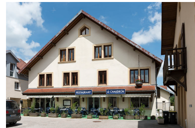
Ancienne ferme et atelier Seguin. Phot. Sonia Dourlot IVR43_20182500938NUC4A
