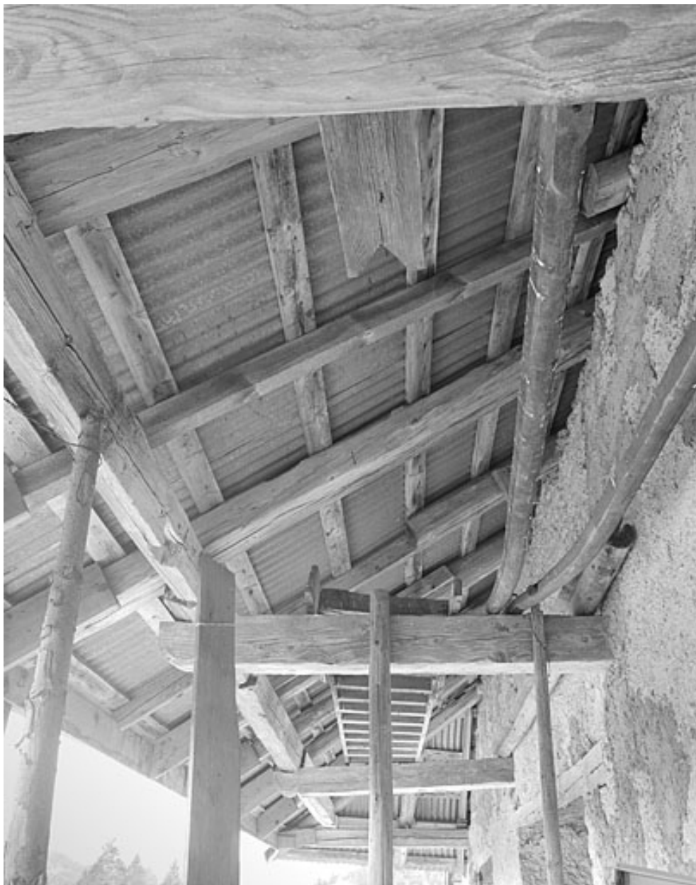
Détail de la charpente de l'avant-toit.
