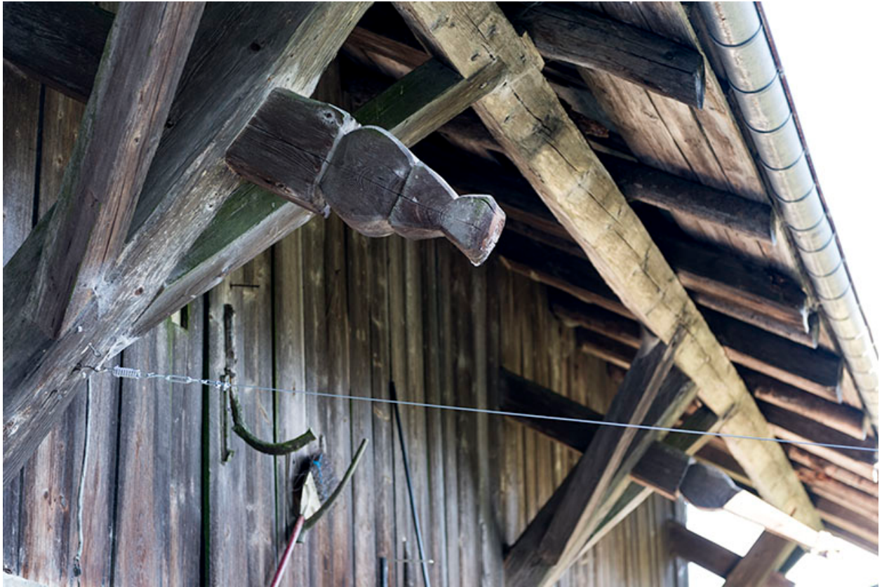
Façade latérale droite : extrémité de pièce de charpente sculptée.
