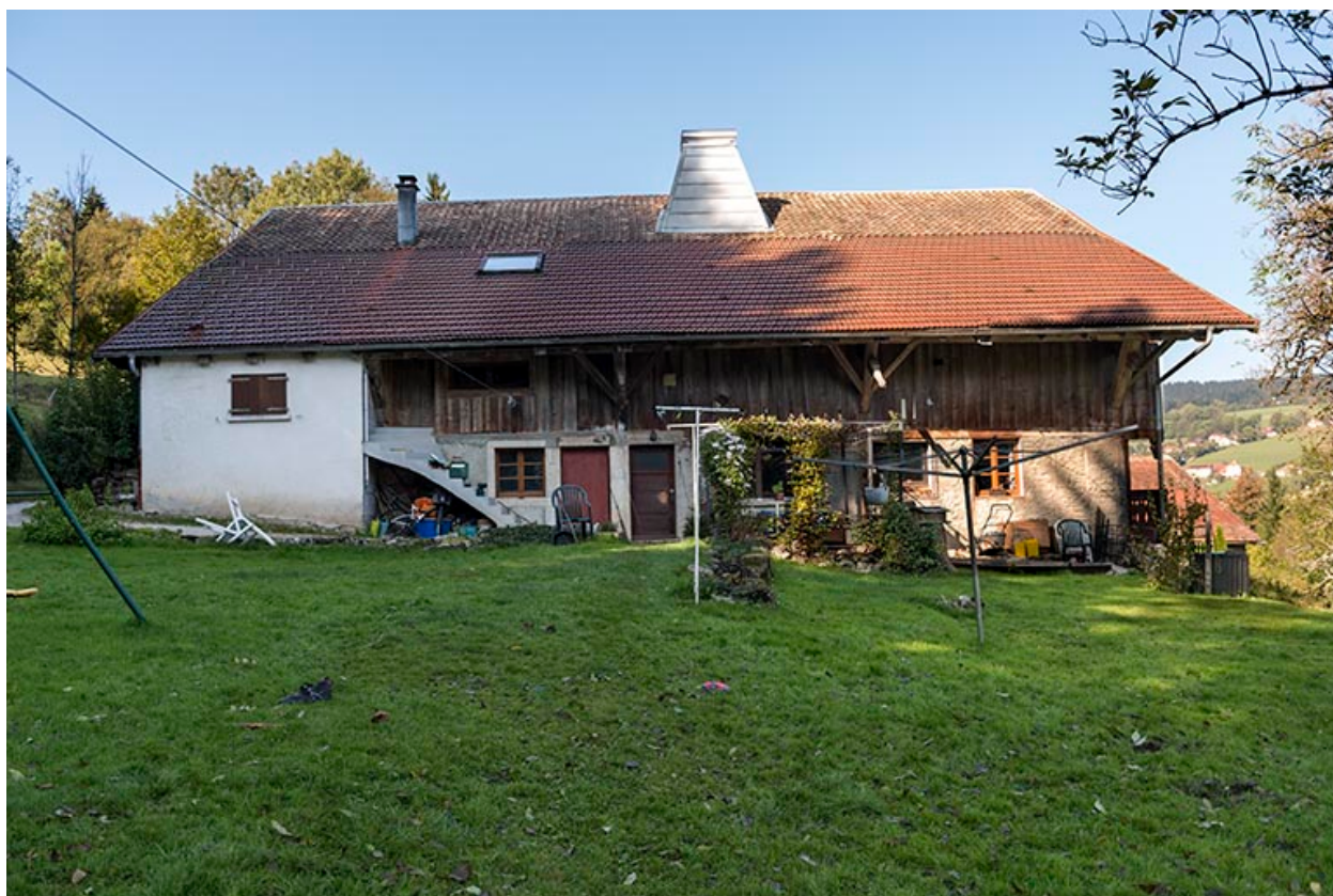
Façade latérale droite.
