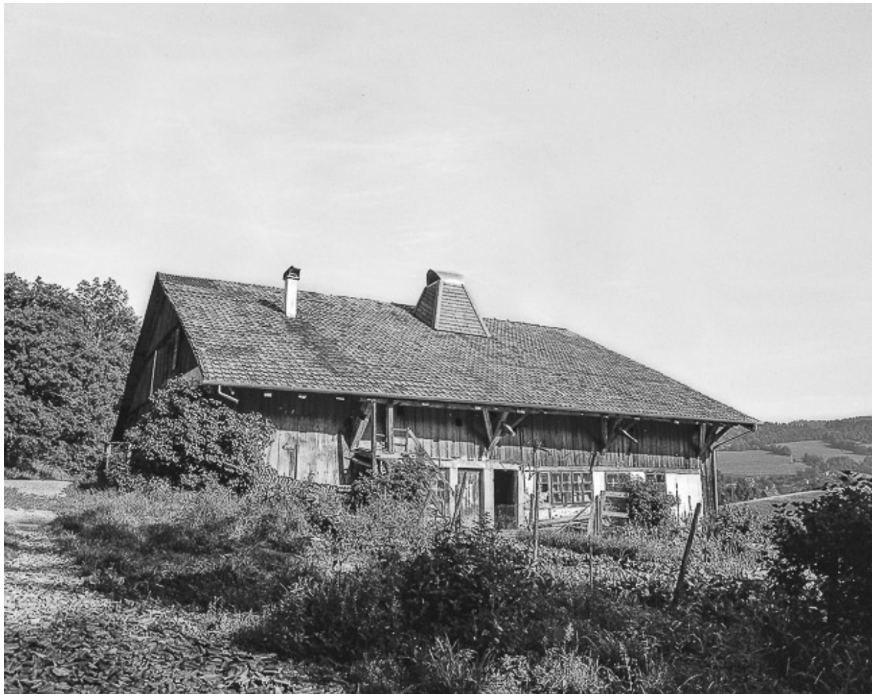
Façade latérale droite, en 1976.
