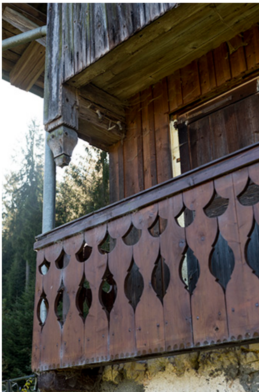
Façade postérieure : détail du garde-corps.
