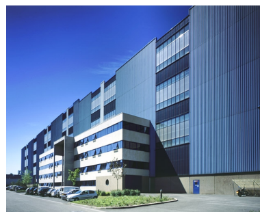
Train : usine Alsthom à Belfort, halle 330 (bureaux et ateliers de montage). Phot. Jérôme Mongreville IVR43_20029000152VA
