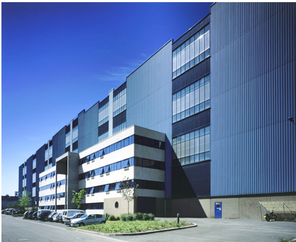
Train : usine Alstom à Belfort, halle 330 (bureaux et ateliers de montage).
