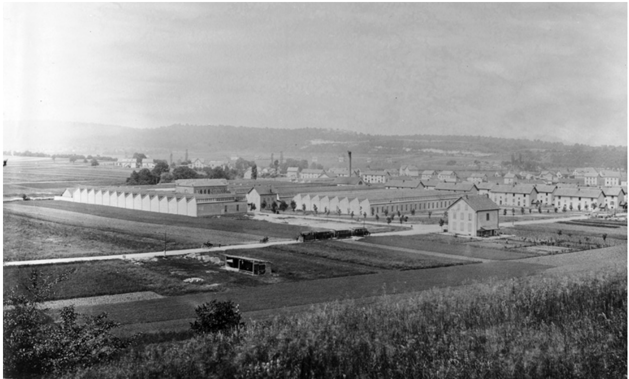
Automobile : Vue éloignée depuis le nord-est [de l'usine des Autos, à Audincourt], [début du 20e siècle].
