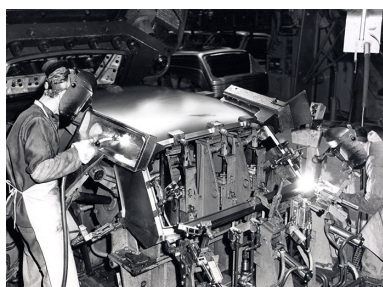
Automobile : assemblage par soudure de la caisse d'une automobile Peugeot, 30 septembre 1965. IVR43_20142500125NUC2A
