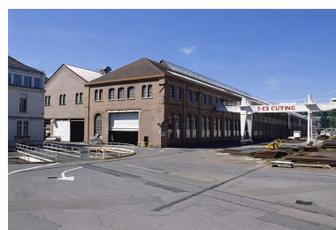
Train : usine Alsthom à Belfort, rue 3 : atelier Traction, pont roulant et dépôt de pièces. Phot. Jérôme Mongreville IVR43_20029000104ZA
