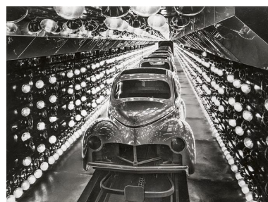
Automobile : Peugeot 203 séchant dans une étuve équipée de lumières infrarouges en 1951. IVR43_20142500103NUC2A
