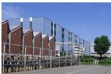
Train : usine Alsthom à Belfort, atelier Traction et halle 330. Phot. Jérôme Mongreville IVR43_20029000073ZA
