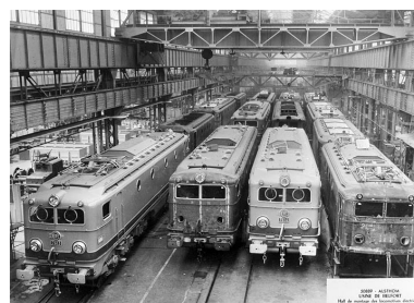
Train : Hall de montage des locomotives électriques [à l'usine Alsthom de Belfort], [vers 1950]. Phot. Jérôme Mongreville IVR43_20029000179X
