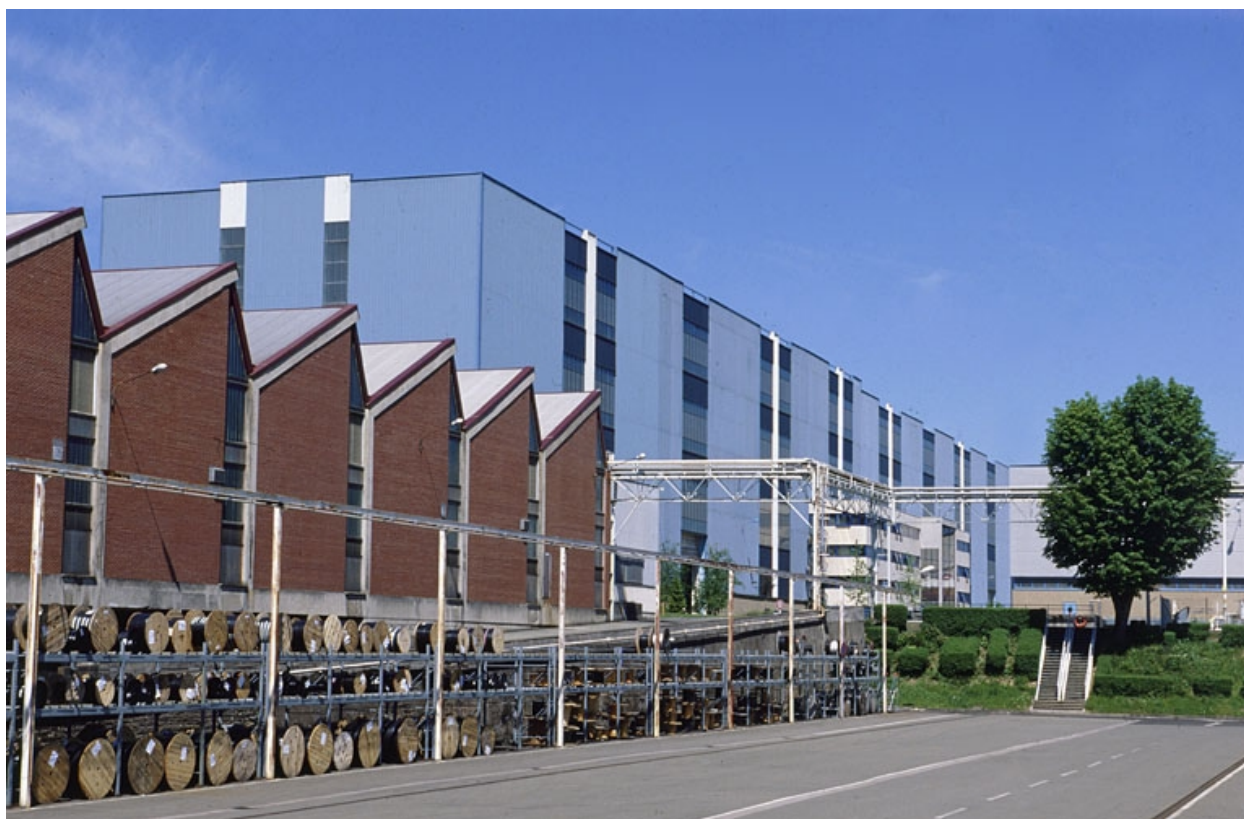
Train : usine Alstom à Belfort, atelier Traction et halle 330.
