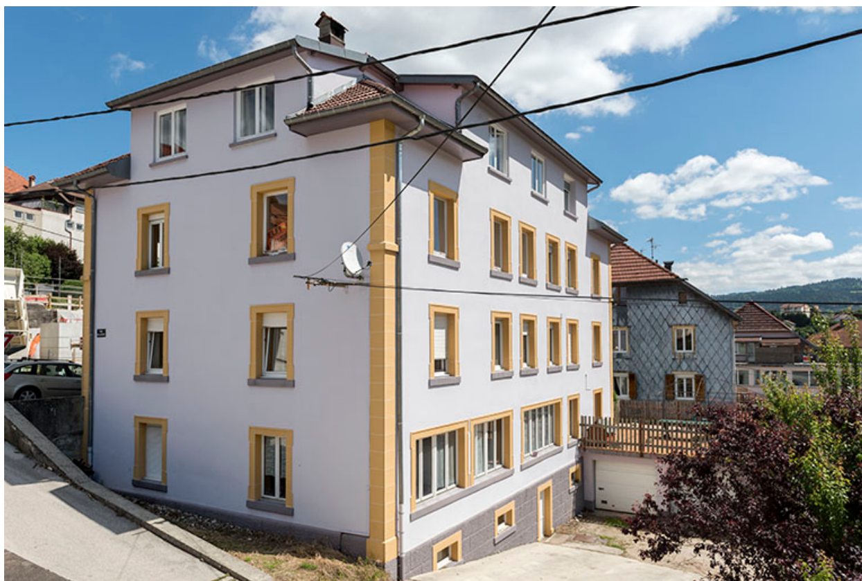
Façades postérieure et latérale droite.
