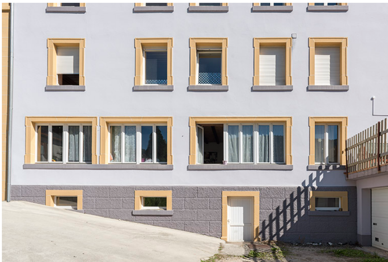
Façade postérieure : baies d'atelier.
