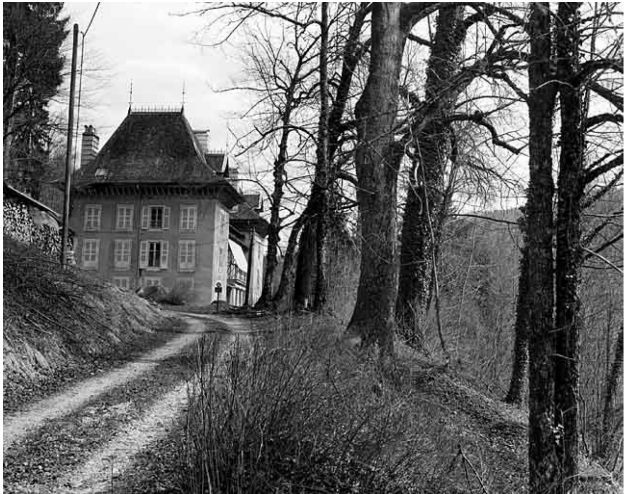
Vue d'ensemble rapprochée, depuis l'ouest.
