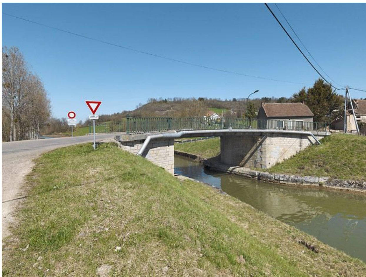
Pont routier isolé de Braux.
