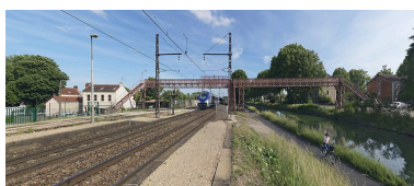
Passerelle à Dijon. Phot. Thierry Kuntz IVR26_20112102921NUC4A
