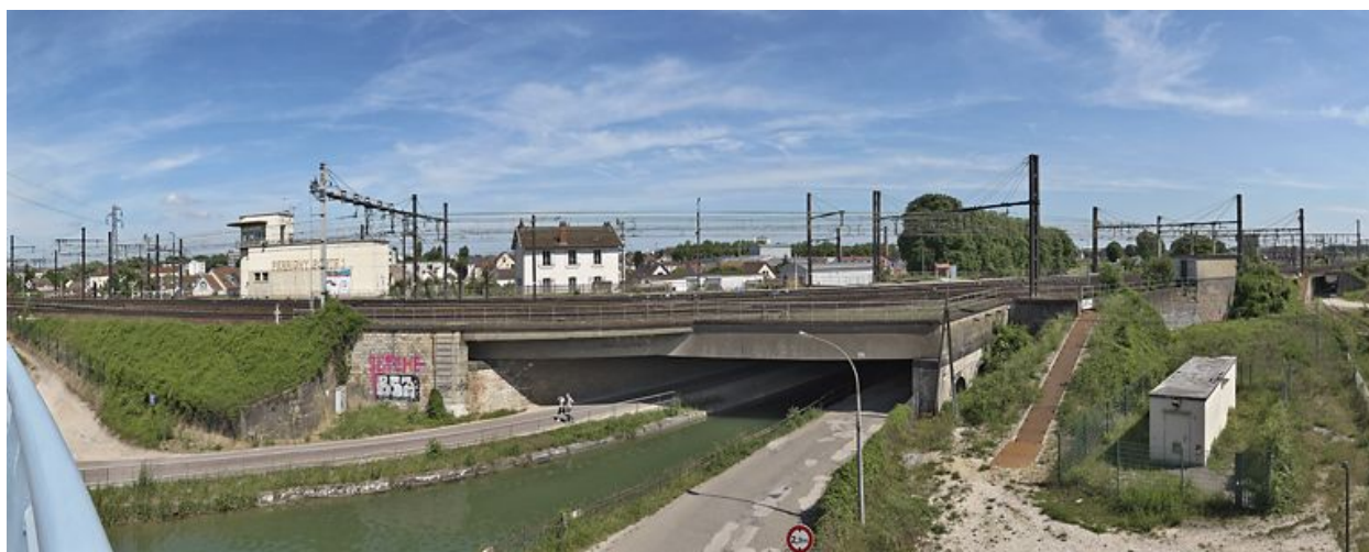
Pont ferroviaire isolé à Dijon.
