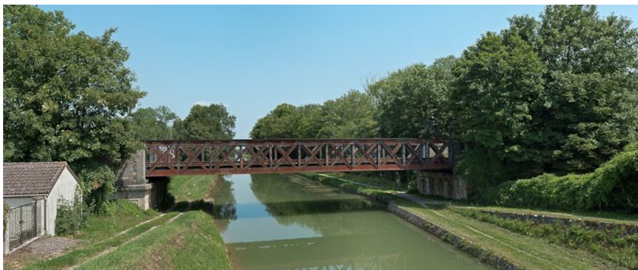
Pont ferroviaire isolé à Saint-Florentin.
