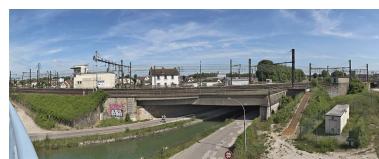
Pont ferroviaire isolé à Dijon. Phot. Thierry Kuntz IVR26_20112102918NUC4A
