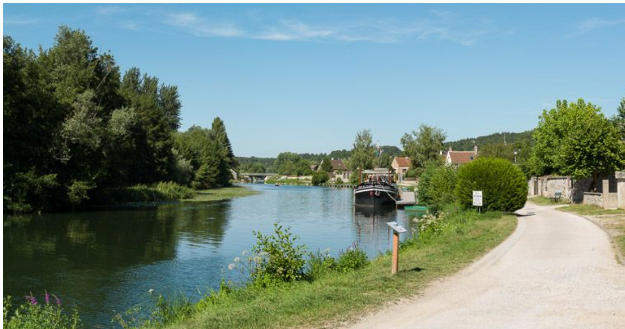
La râcle, en aval du site d'écluse.
