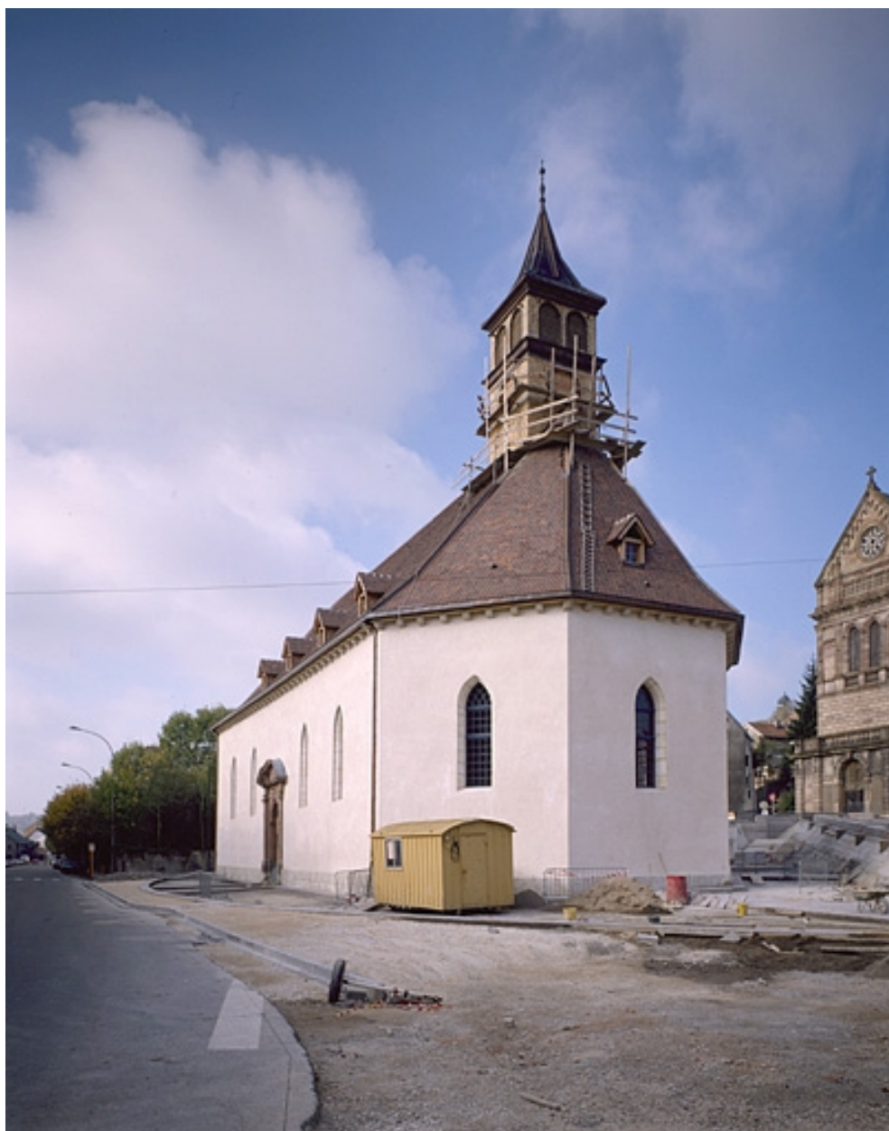
Vue d'ensemble des faces est et sud.
