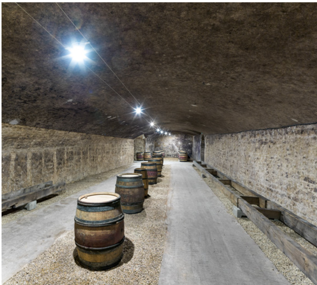
Caves, rez-de-chaussée : vaisseau central.
