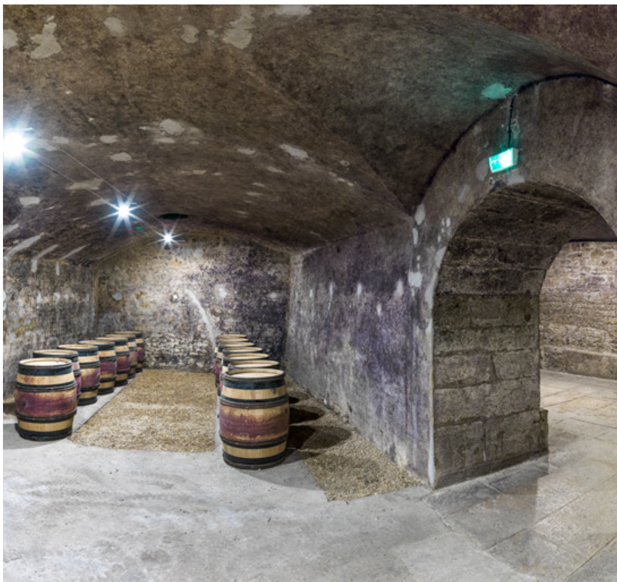
Caves, rez-de-chaussée : voûte en arc segmentaire.
