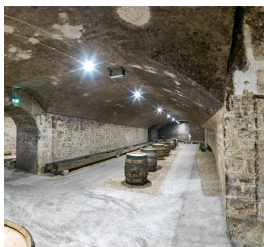
Caves, rez-de-chaussée : vue générale. Phot. Pierre-Marie Barbe-Richaud IVR26_20152100898NUC4A
