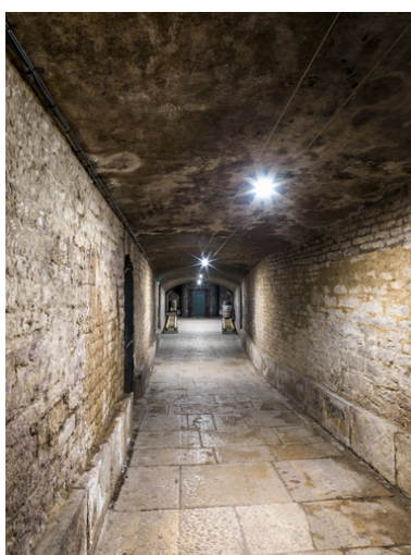
Galerie menant vers les caves, rez-de-chaussée. Phot. Pierre-Marie Barbe-Richaud IVR26_20152100888NUC4A
