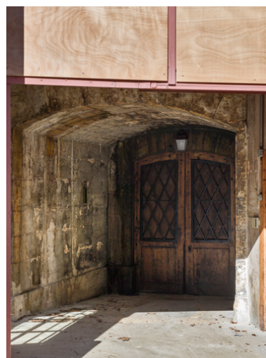
Entrée de la tour au rez-de-chaussée. Phot. Pierre-Marie Barbe-Richaud IVR26_20152100885NUC4A
