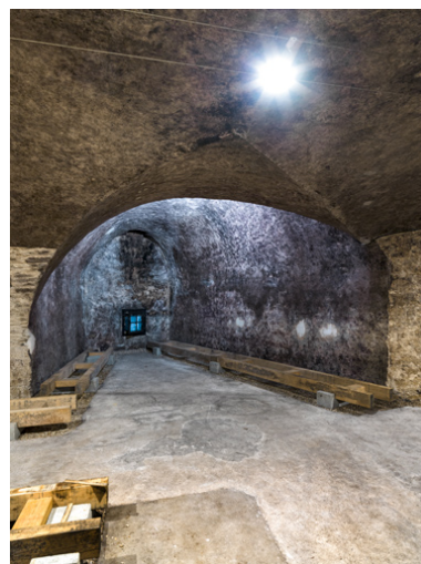
Caves, rez-de-chaussée : niche d'une embrasure. Phot. Pierre-Marie Barbe-Richaud IVR26_20152100910NUC4A
