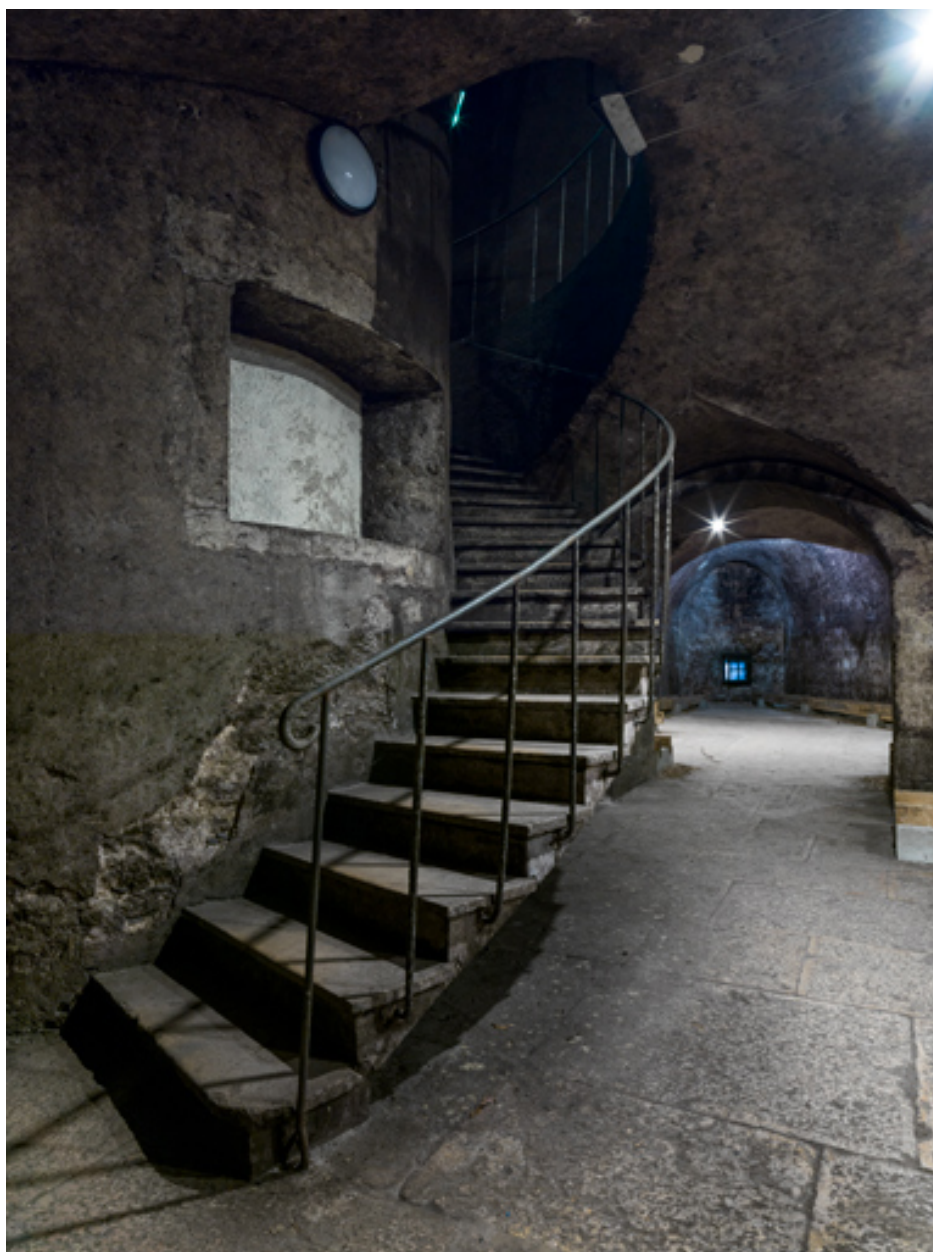
Caves, rez-de-chaussée : le monte-charge avec l'escalier tournant.
