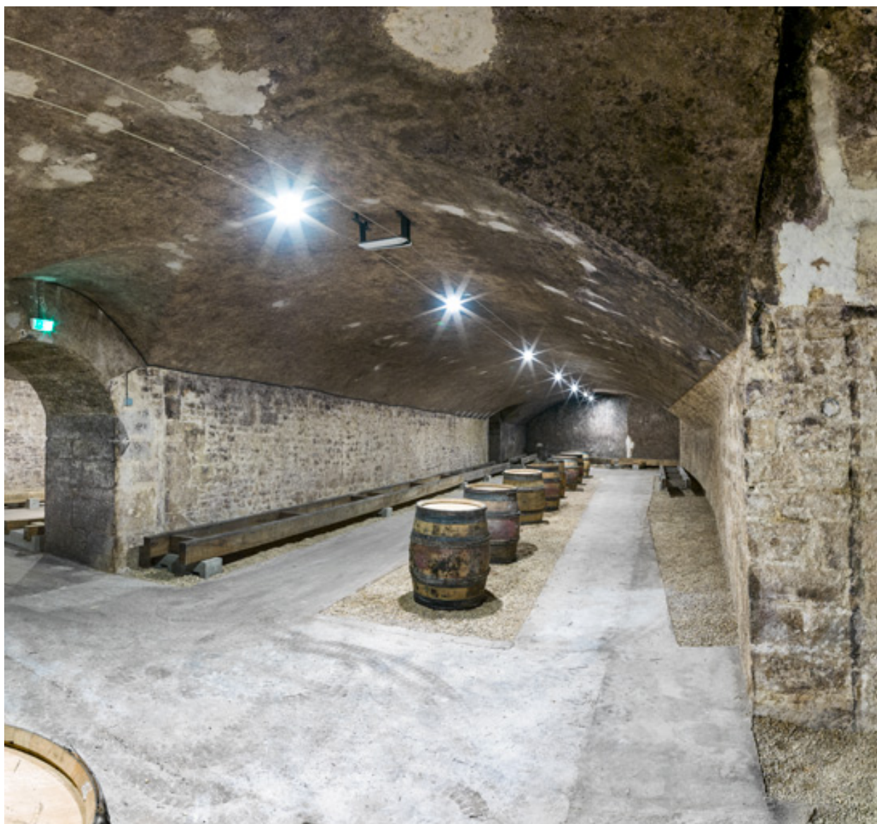
Caves, rez-de-chaussée : vue générale.
