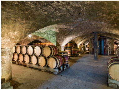
Caves, troisième niveau. Phot. Pierre-Marie Barbe-Richaud IVR26_20152100929NUC4A
