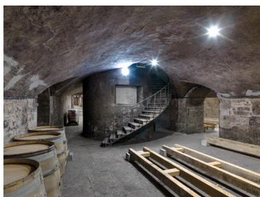
Caves, rez-de-chaussée : vaisseau central et le monte-charge. Phot. Pierre-Marie Barbe-Richaud IVR26_20152100907NUC4A
