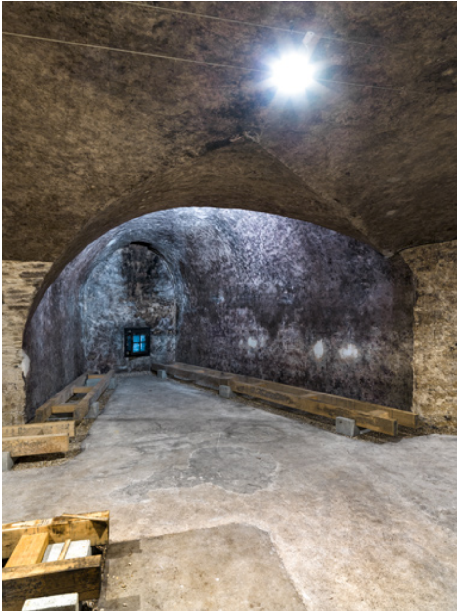
Caves, rez-de-chaussée : niche d'une embrasure.
