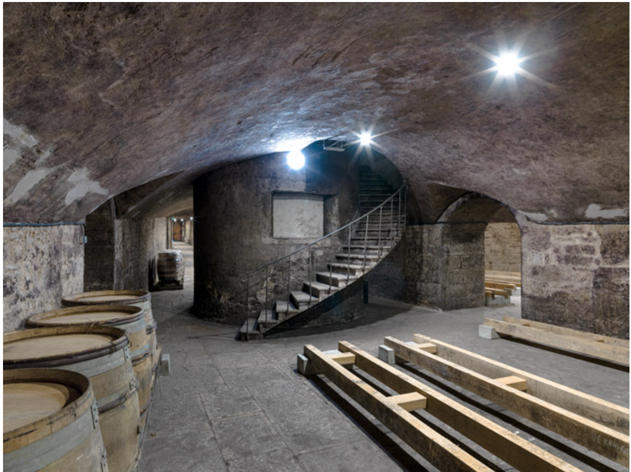
Caves, rez-de-chaussée : vaisseau central et le monte-charge.
