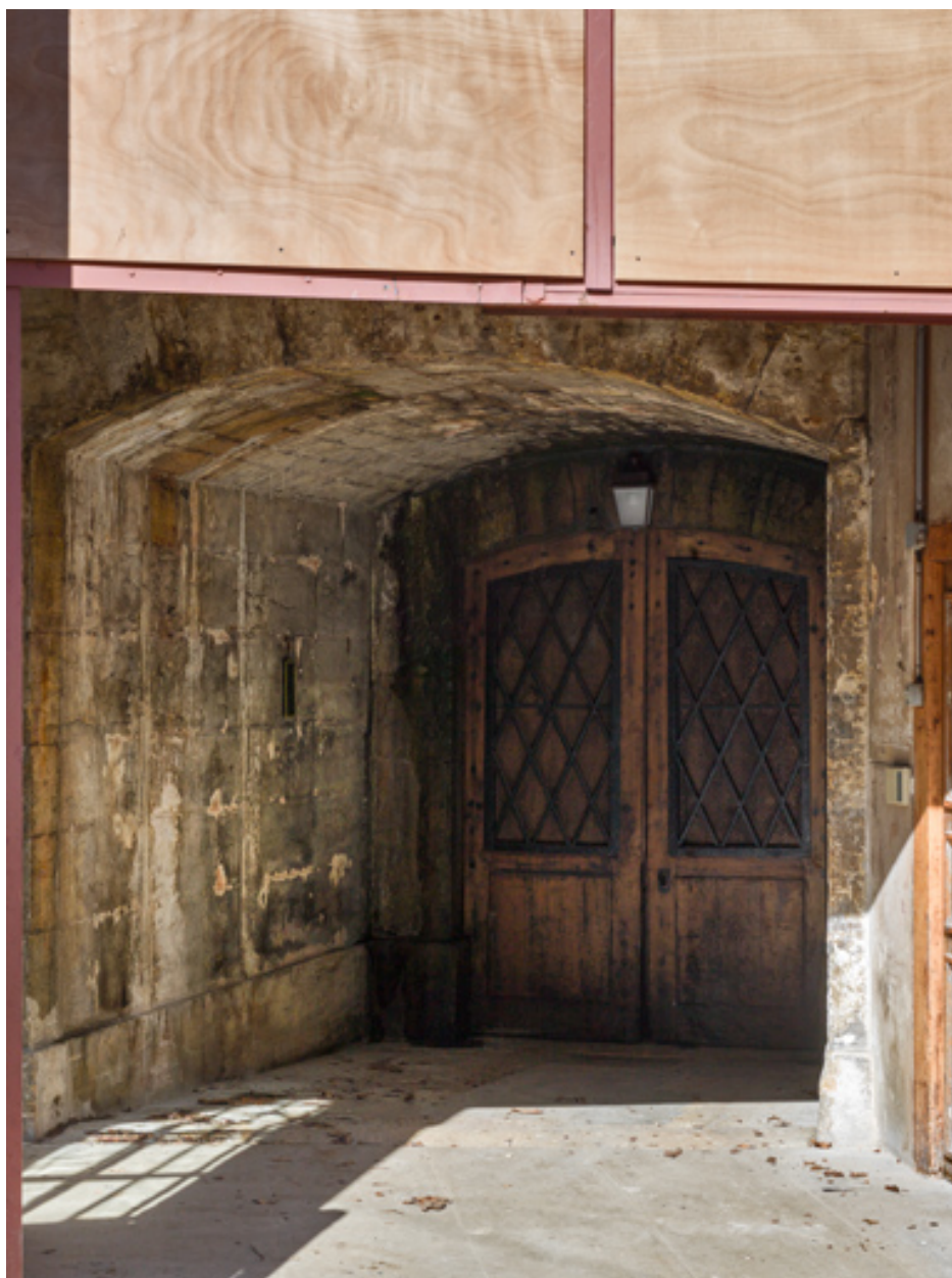
Entrée de la tour au rez-de-chaussée.
