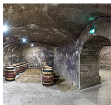
Caves, rez-de-chaussée : voûte en arc segmentaire. Phot. Pierre-Marie Barbe-Richaud IVR26_20152100897NUC4A
