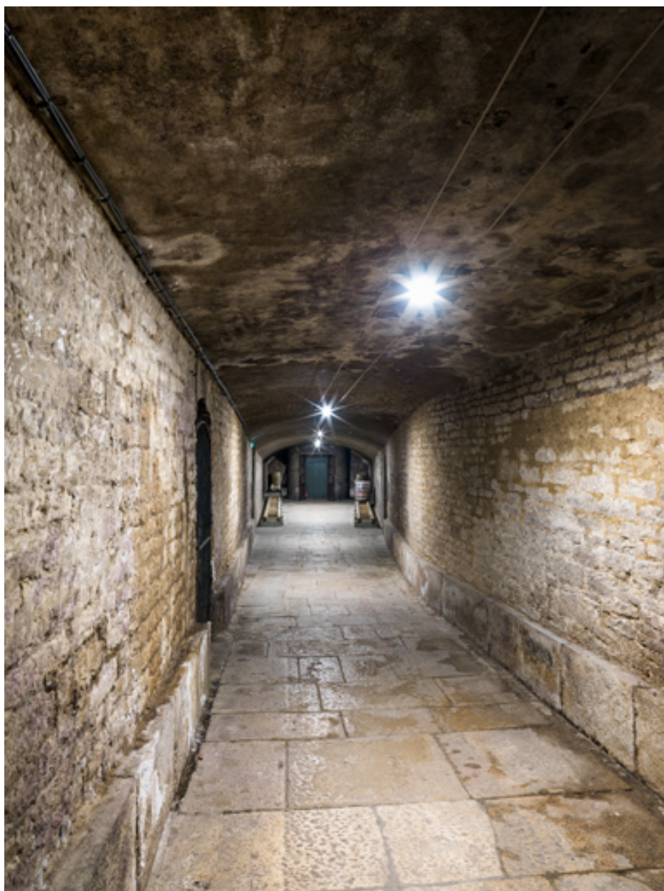
Galerie menant vers les caves, rez-de-chaussée.
