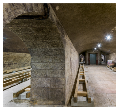
Caves, rez-de-chaussée : mur de refend entre deux vaisseaux. Phot. Pierre-Marie Barbe-Richaud IVR26_20152100893NUC4A
