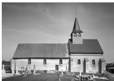
Elévation droite Phot. Michel Rosso IVR26_19862100979V
