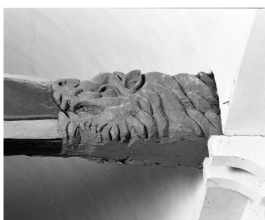
Charpente de la nef, détail du 3e entrait, revers Phot. Michel Thierry IVR26_19862100989X
