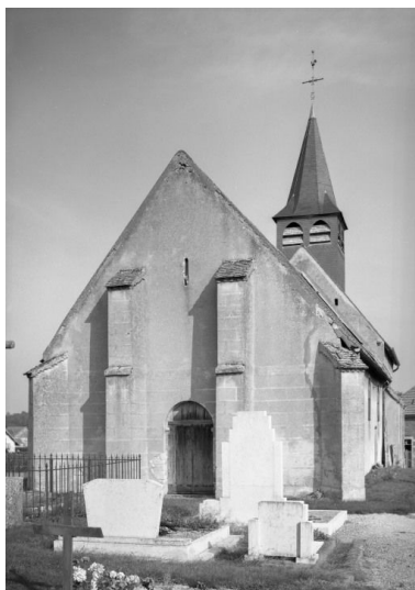
Elévation antérieure Phot. Michel Rosso IVR26_19862100977V
