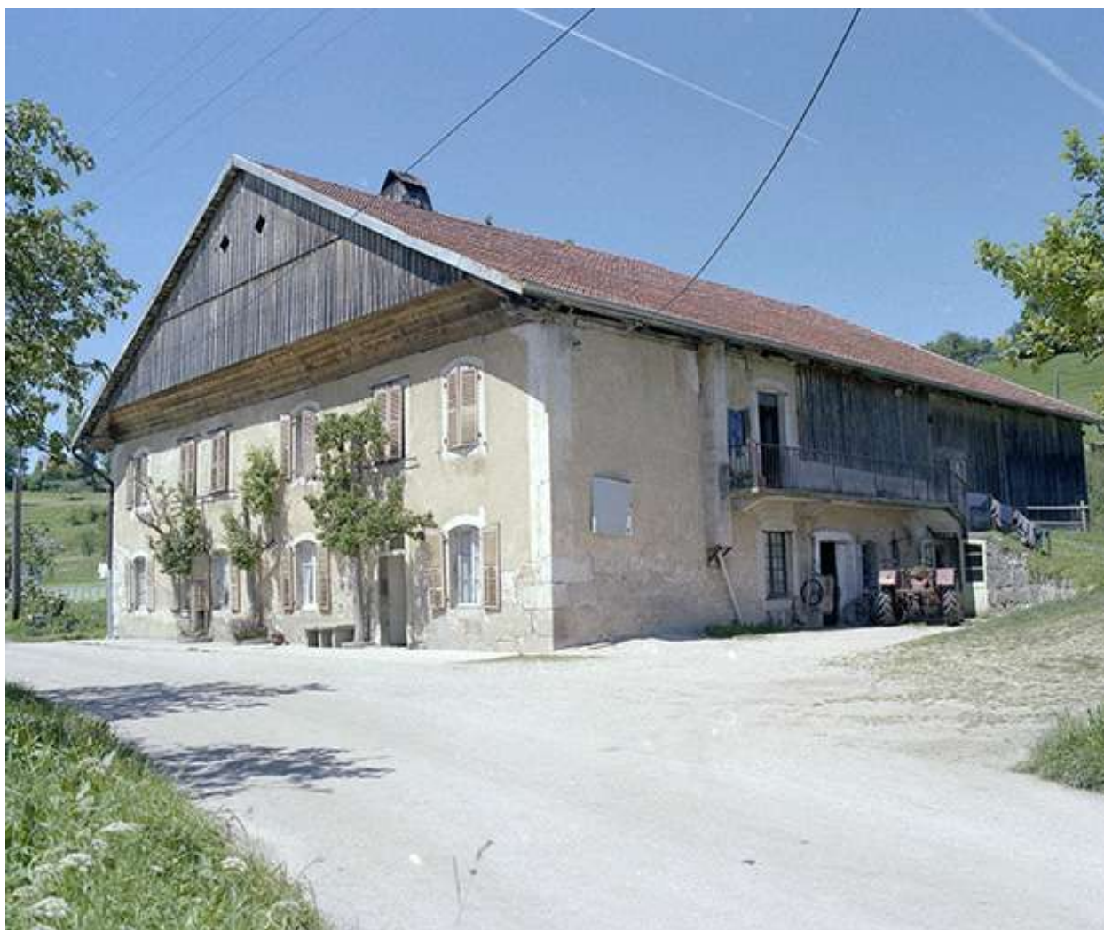
Façades antérieure et latérale droite.
