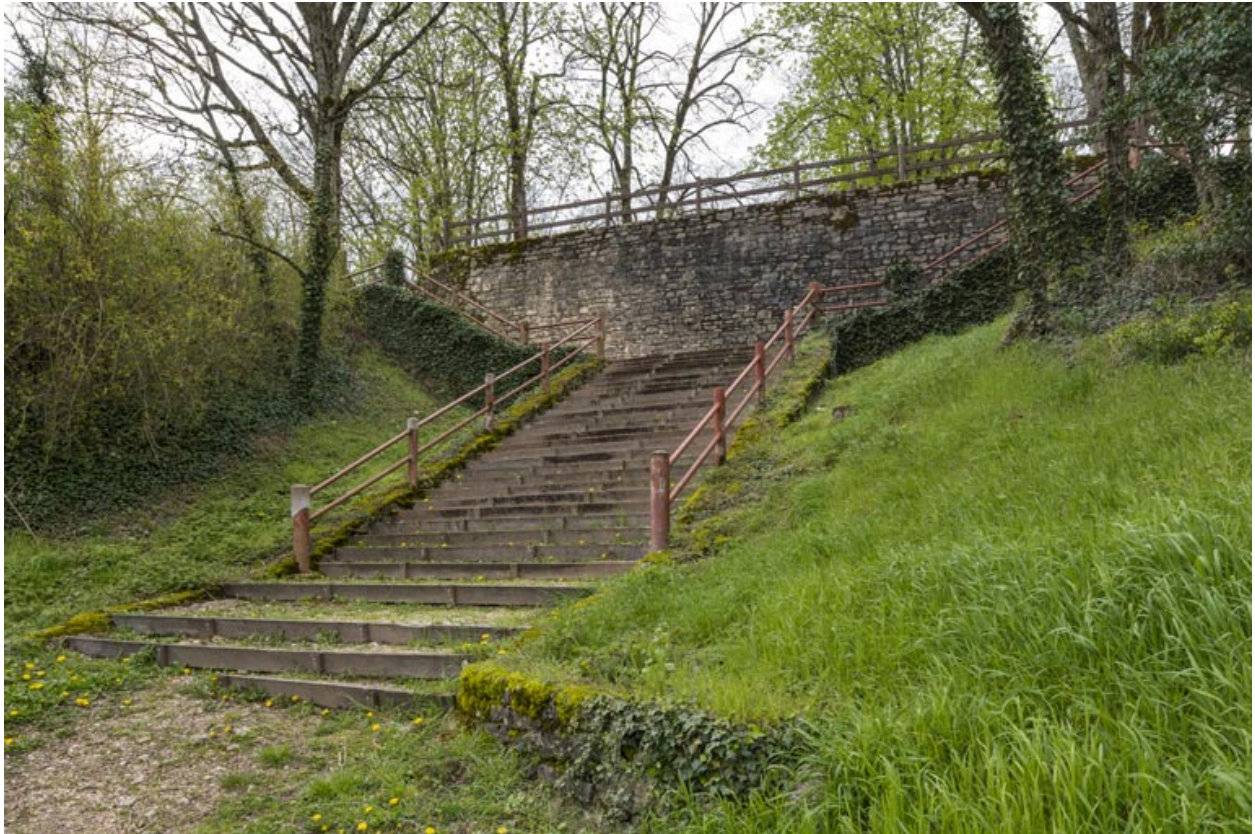
Escalier et mur de soutènement.
