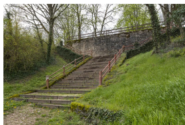
Escalier et mur de soutènement. Phot. Pierre-Marie Barbe-Richaud IVR26_20242100202NUC4A
