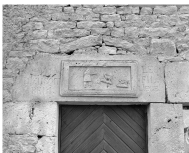
Linteau de porte d'une ferme. Phot. Yves Sancey IVR43_19812500250X
