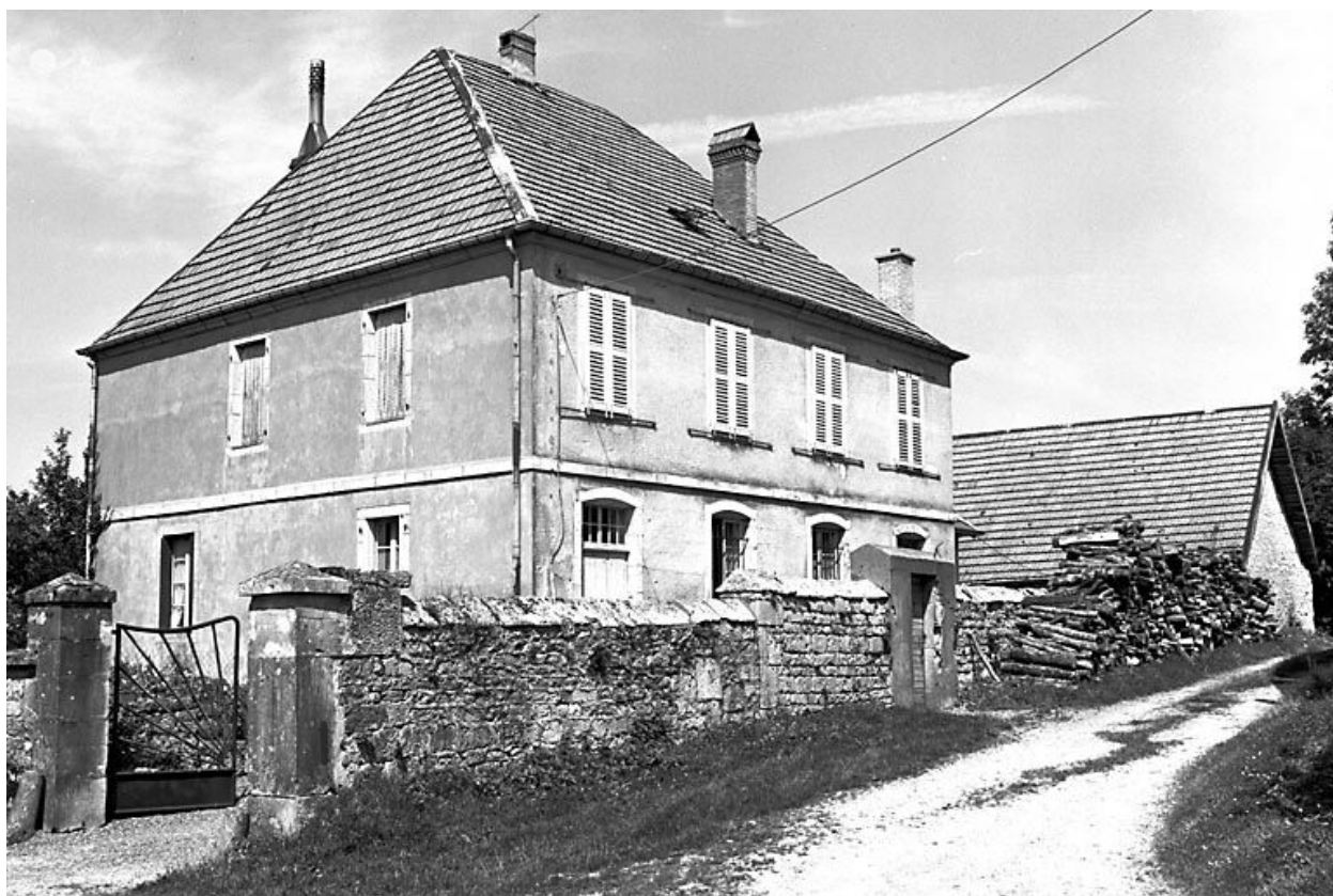
Presbytère situé rue de l'Eglise.
