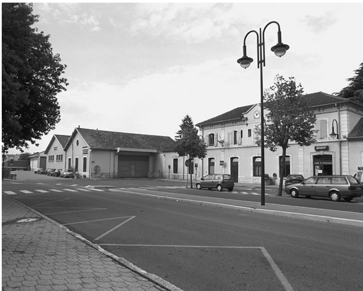
Entrepôts et cour, depuis le nord-est.
