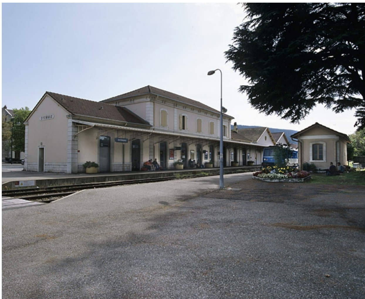
Vue d'ensemble, depuis le nord-ouest (côté Andelot-en-Montagne).
