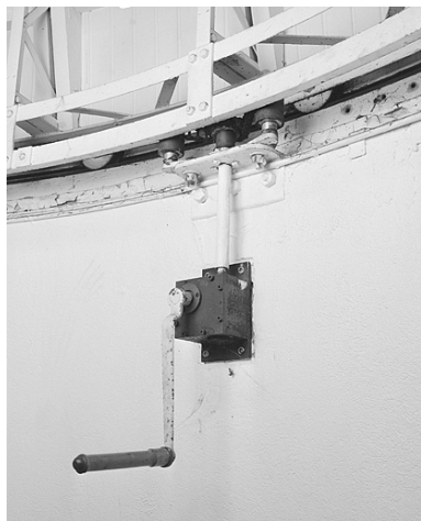
Système de rotation du dôme : manivelle, pignon denté entre deux galets et chaîne d'entraînement. Phot. Yves Sancey IVR43_20032501161X
