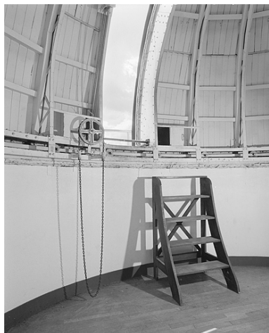
Vue d'ensemble du système d'ouverture du dôme. Phot. Yves Sancey IVR43_20032501158X
