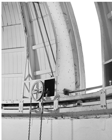
Système d'ouverture du dôme : chaîne et vis sans fin. Phot. Yves Sancey IVR43_20032501157X
