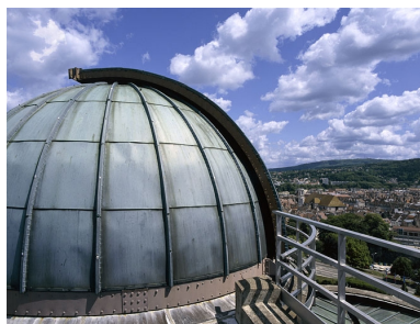
Le dôme, vu de profil. Phot. Yves Sancey IVR43_20032501127XA
