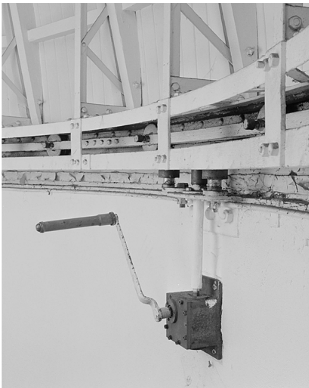
Système de rotation du dôme.
