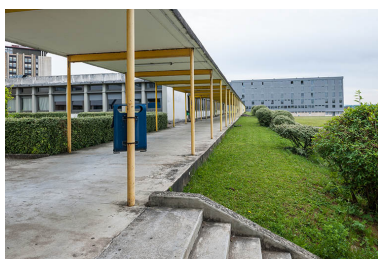
Passage couvert menant au bâtiment d'internat. Phot. Jérôme Mongreville IVR43_20143900201NUC4A
