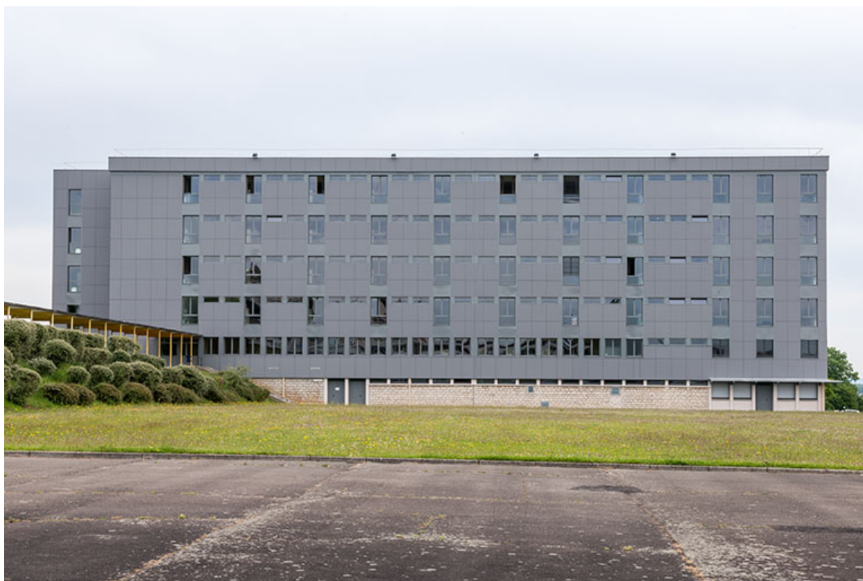
Internat : façade antérieure.
