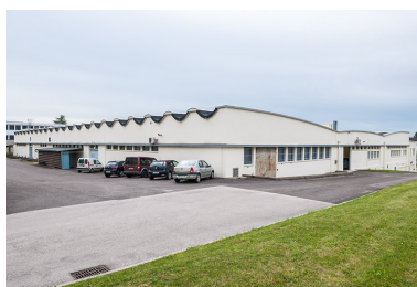
Ateliers : vue générale des façades arrière. Phot. Jérôme Mongreville IVR43_20143900195NUC4A
