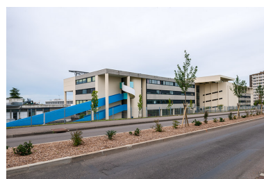
Externat : façade postérieure. Phot. Jérôme Mongreville IVR43_20143900180NUC4A
