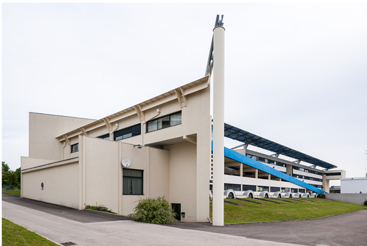
Bâtiment d'externat : pignon ouest.
