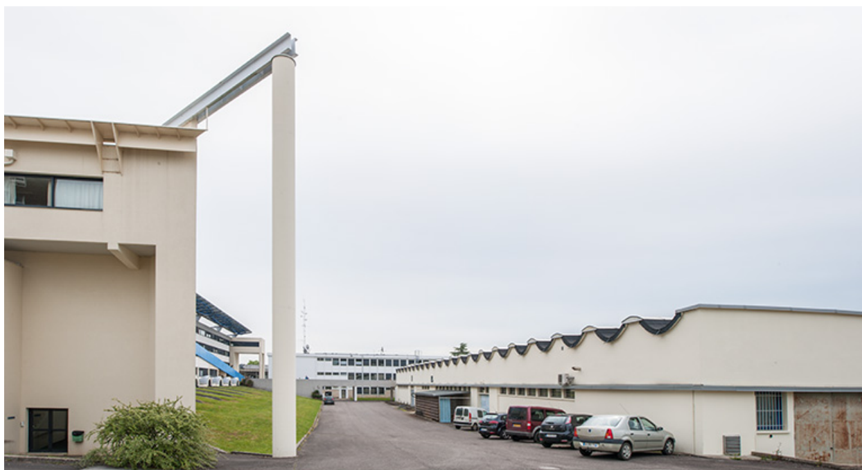
Ateliers : façade antérieure.
