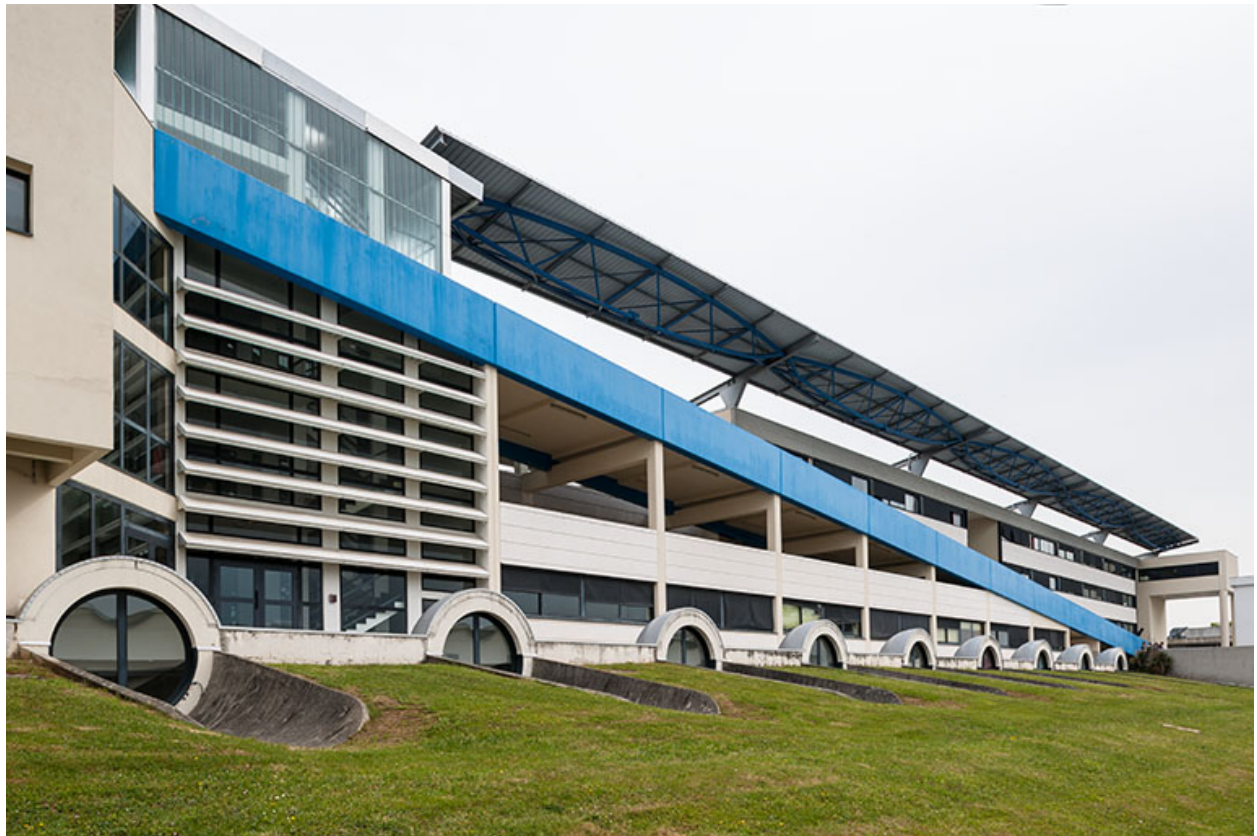
Bâtiment d'externat : façade antérieure.
