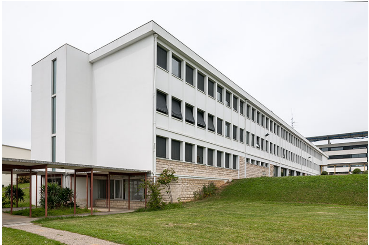
Externat : ancien bâtiment, pignon sud.
