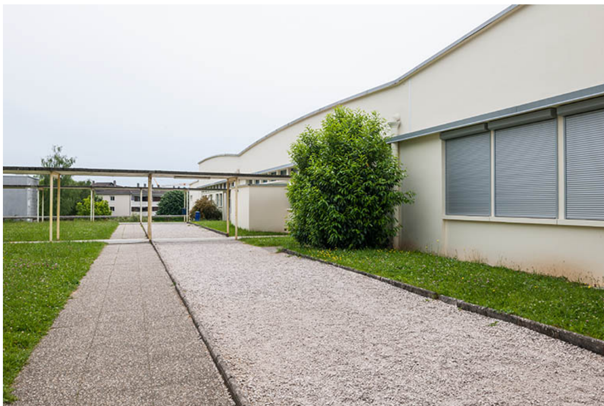
Passages entre Ateliers et externat.
