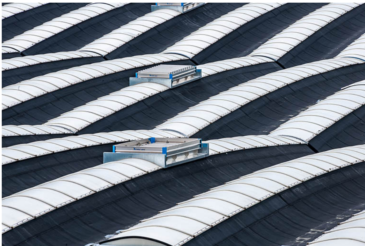
Ateliers : détail de la toiture
