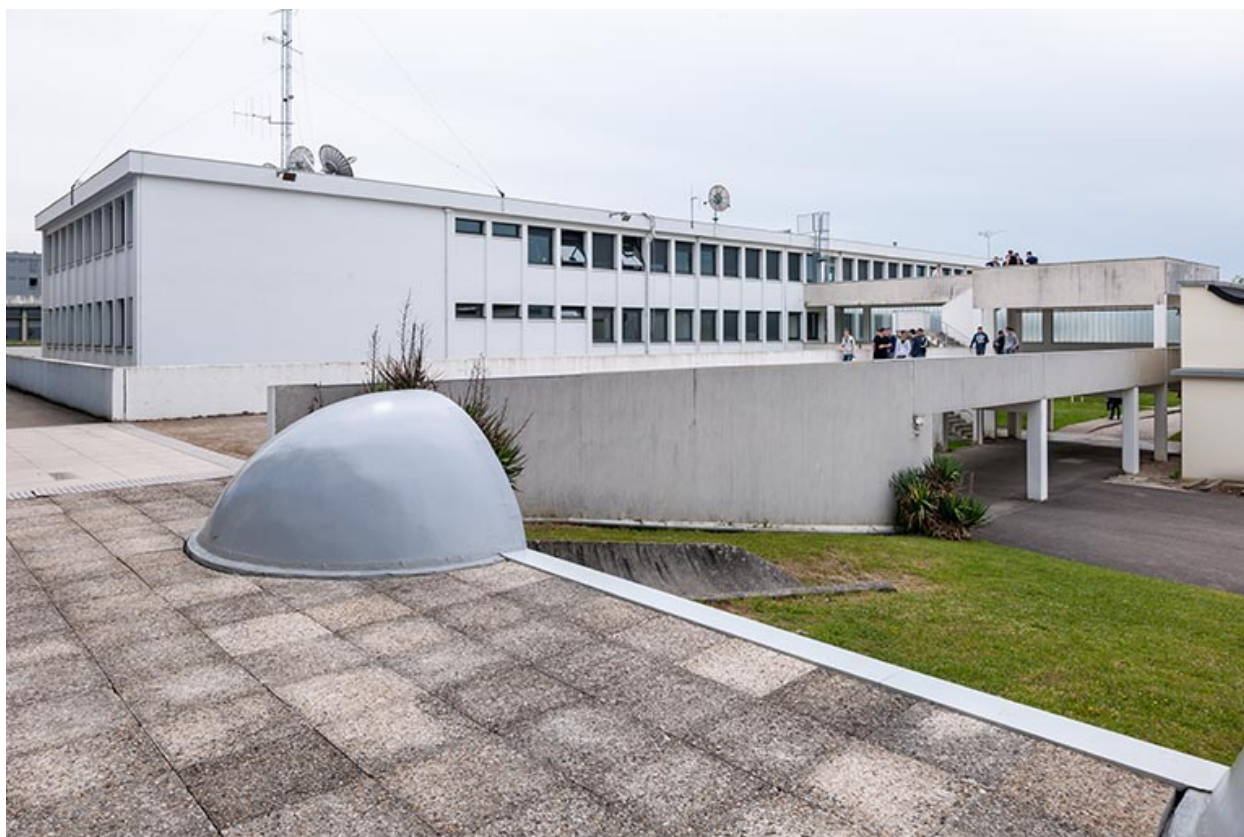
Externat : façade postérieure de l'ancien externat réaménagé.
