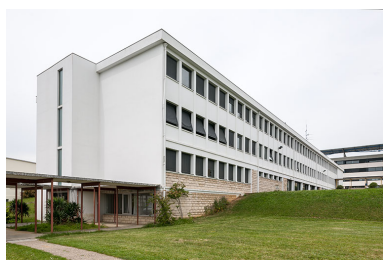
Externer : ancien bâtiment, pignon sud. Phot. Jérôme Mongreville IVR43_20143900194NUC4A
