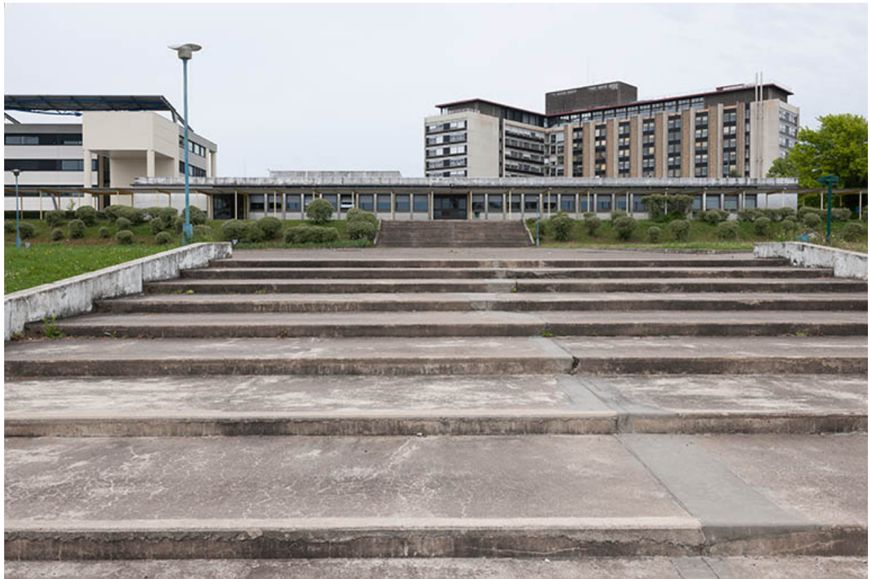
Façades postérieures des bâtiments d'externat et restauration
