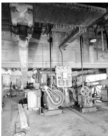
Systèmes de descente des châssis porte-lames. Bielle au premier plan.
