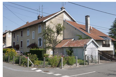
Habitation vue de trois quarts droite. Phot. Jérôme Mongreville IVR43_20112502231NUC4A
