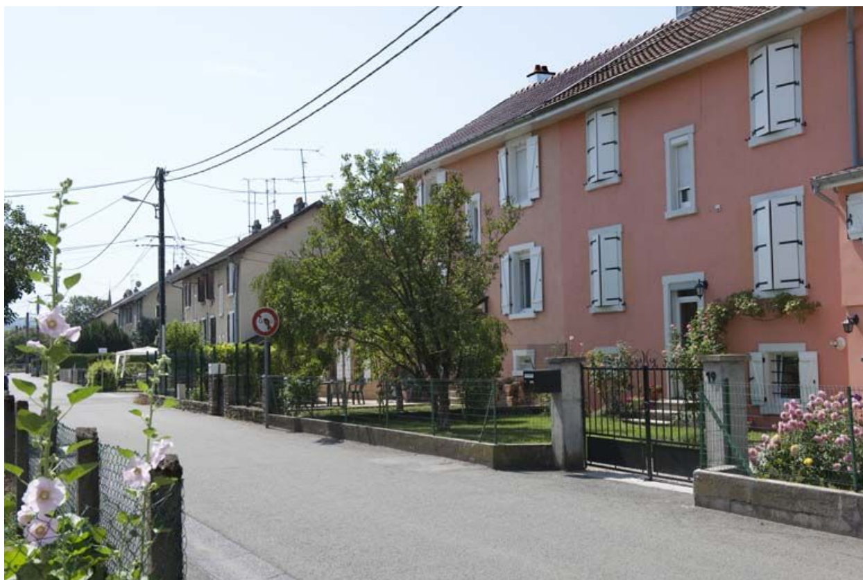
Vue d'ensemble rue du 11 Novembre.
