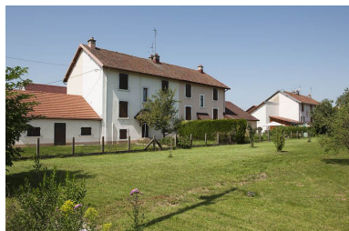
Façade postérieure des habitations. Phot. Jérôme Mongreville IVR43_20112502228NUC4A
