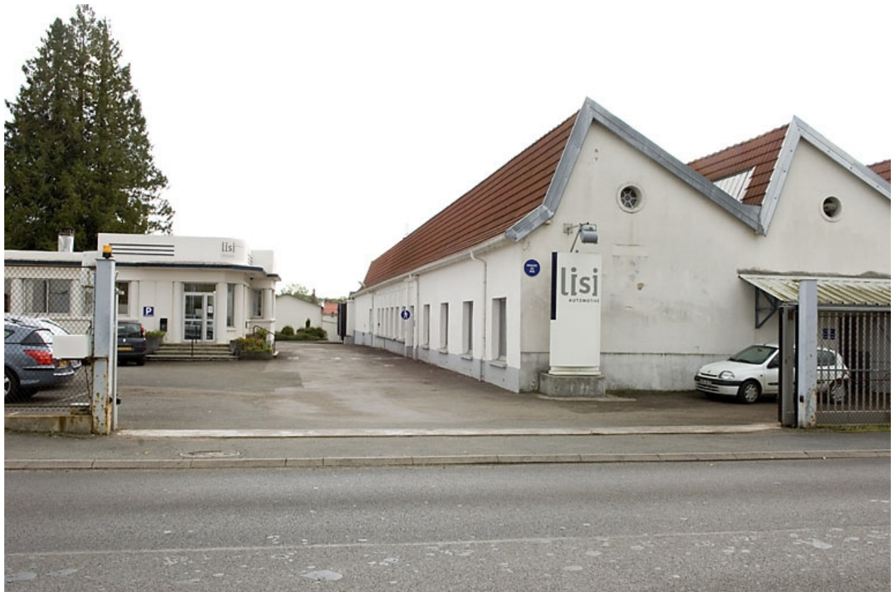
Entrée de l'usine.
