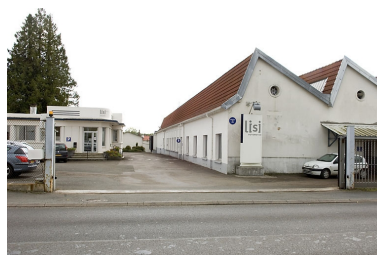
Entrée de l'usine. Phot. Jérôme Mongreville IVR43_20077000520NUCA
