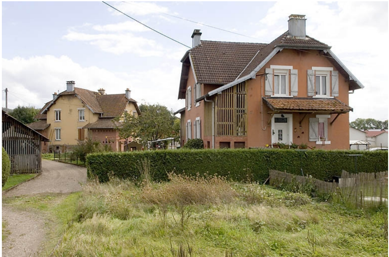
Maisons ouvrières à quatre logements.
