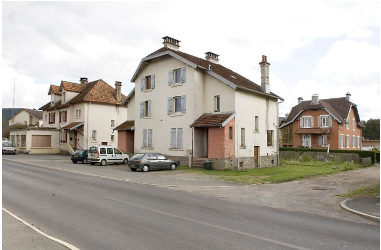
Vue d'ensemble de la cité ouvrière.
