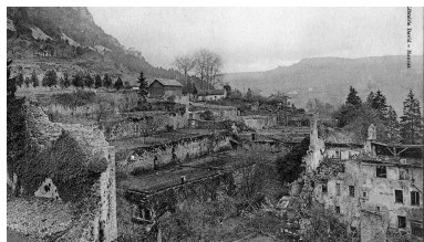
Vue des terrasses en terre-plein depuis la tour de Chambenoz.
