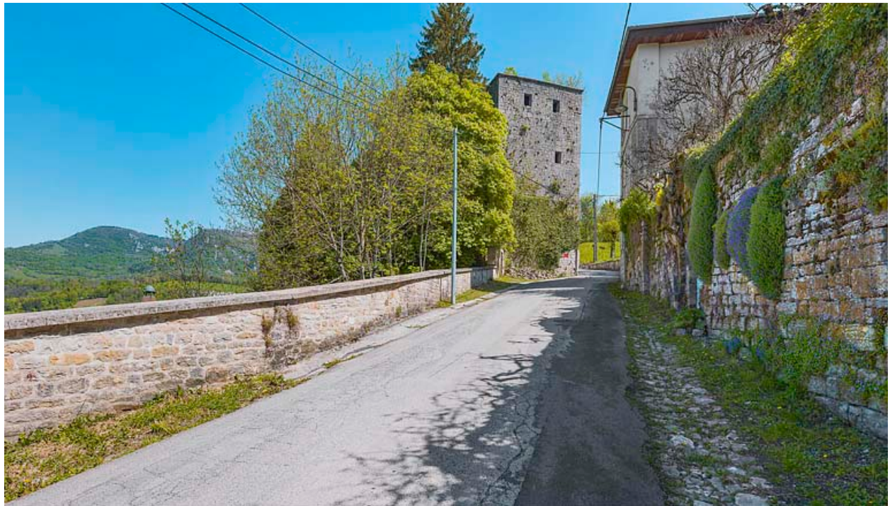
Vue depuis le milieu de la rue. Le couvent bordait le mur à droite.
