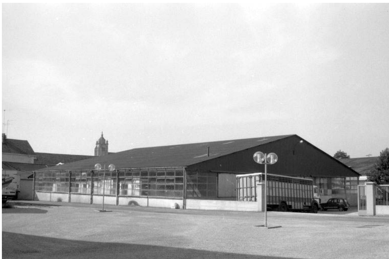
Remise (ancienne usine U.M.D.).
