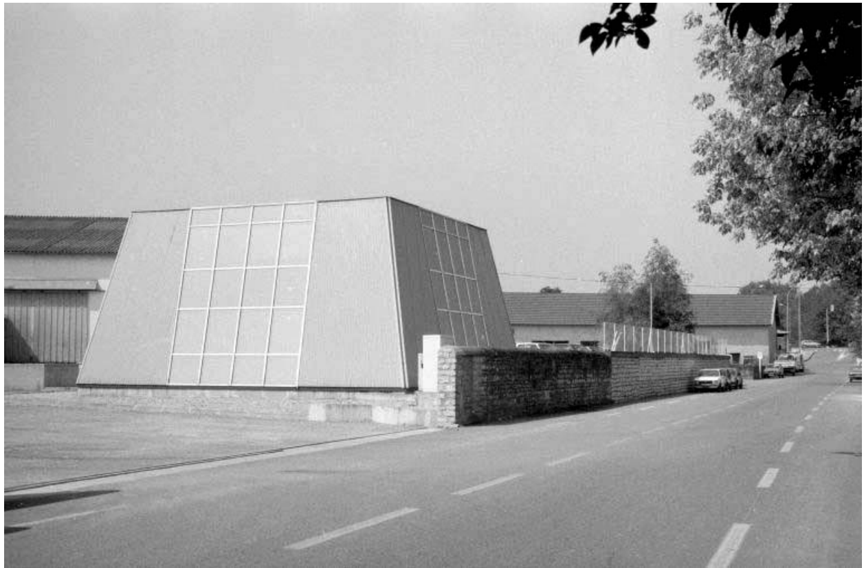
Bâtiment de la société SERIG.
