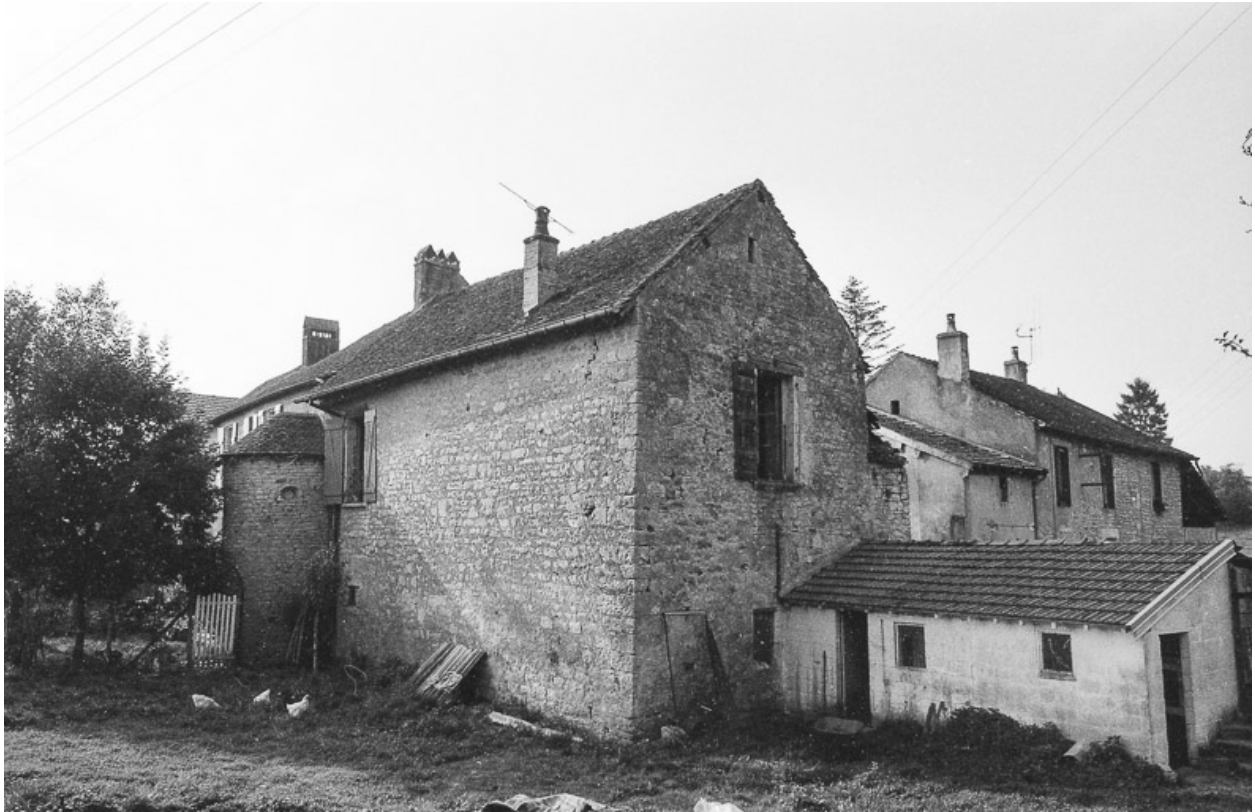
Façade latérale droite.
