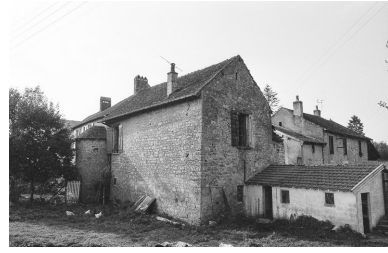
Façade latérale droite. Phot. Bernard Lardière IVR43_19797000311Z
