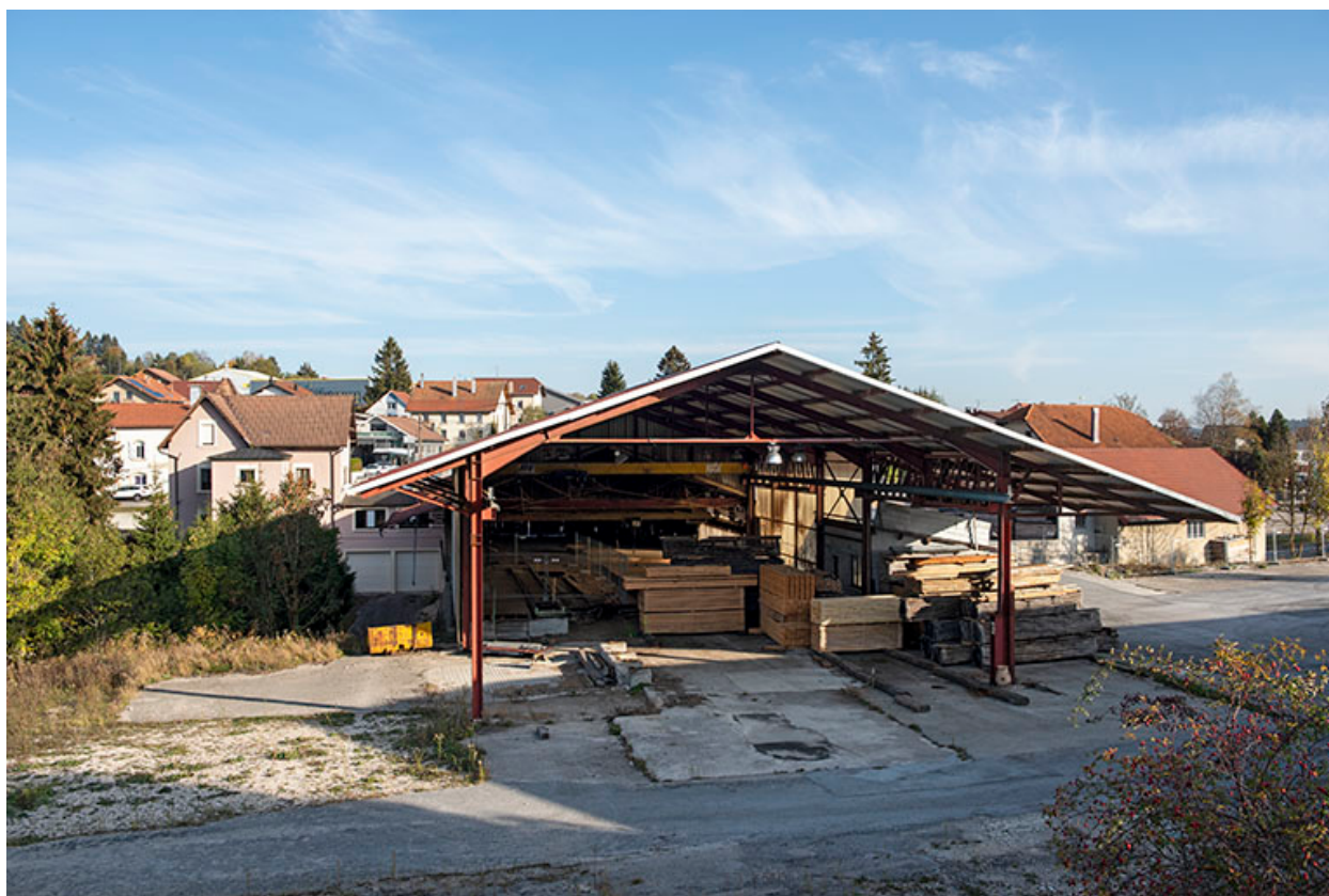
Atelier récent : façade sud.
