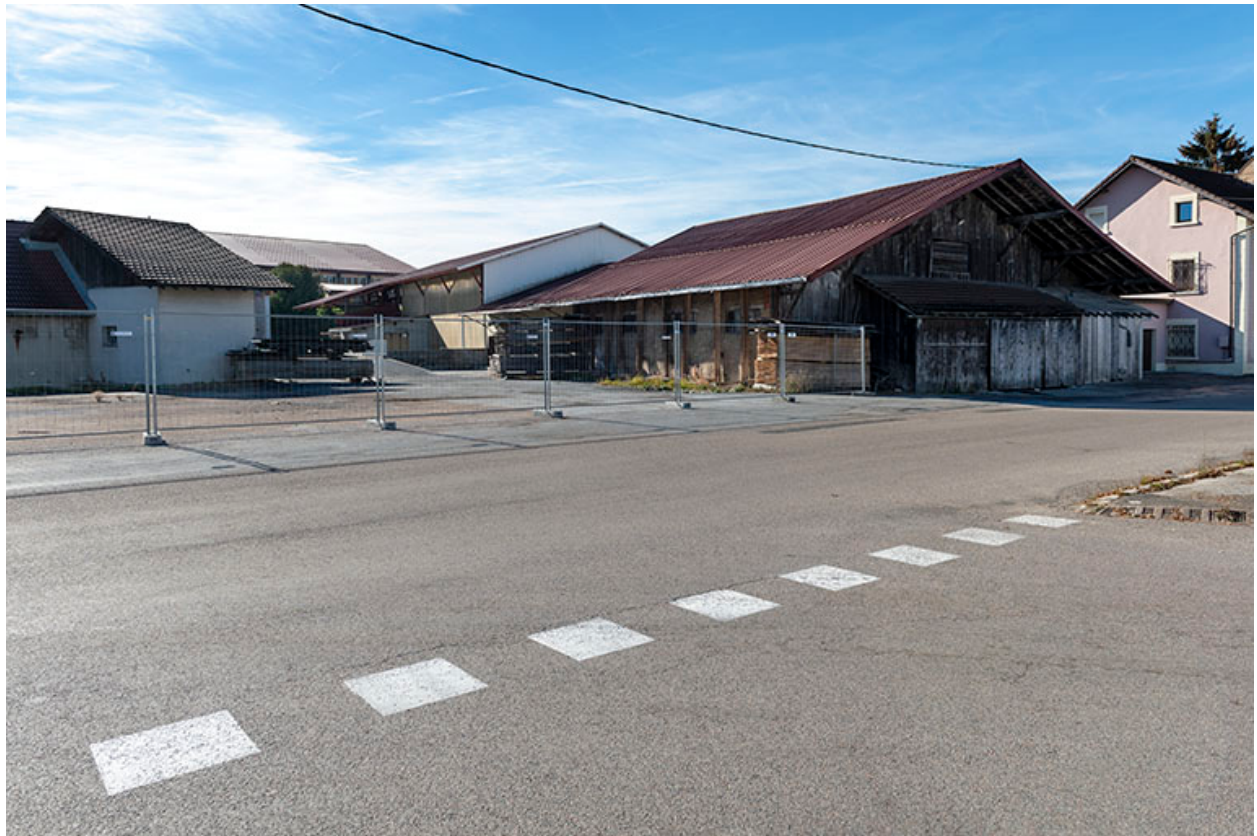
Ateliers de fabrication, depuis le nord-est.
