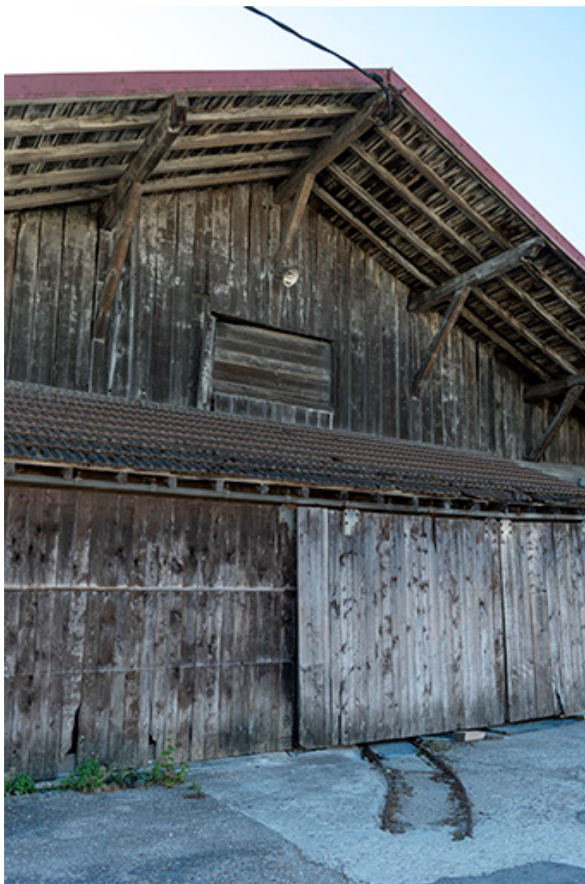
Atelier de 1919 : façade antérieure (nord).
