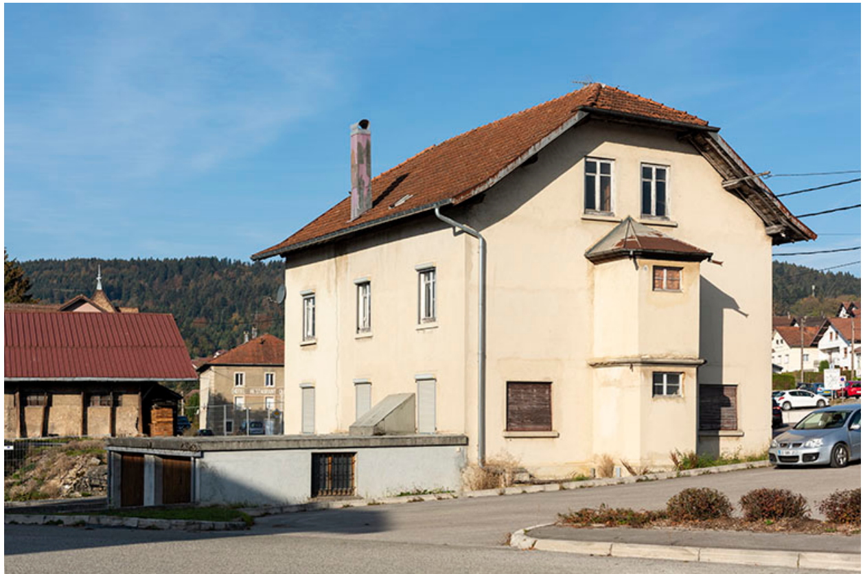
Maison de 1919 : façades postérieure et latérale gauche.
