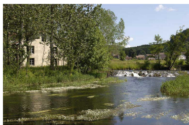
Le moulin et son barrage depuis le sud. Phot. Jérôme Mongreville IVR43_20057000233NUCA
