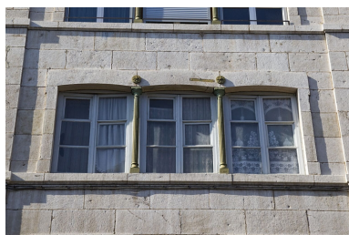
Détail d'une baie horlogère du premier étage. Phot. Yves Sancey IVR43_20122500460NUC2A
