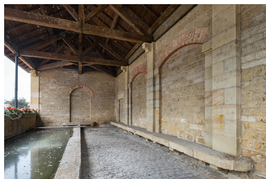
L'intérieur du lavoir en bais, depuis l'entrée. Phot. Jérôme Mongreville IVR43_20217000523NUC4A
