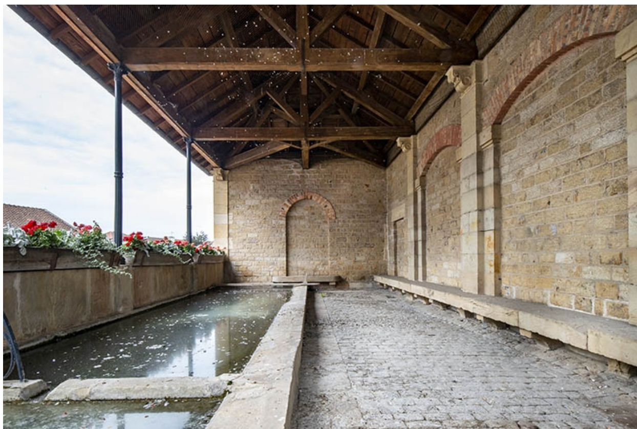
L'intérieur de la fontaine-lavoir, depuis l'entrée.
