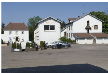
Logements et bureaux depuis la cour. Phot. Jérôme Mongreville IVR43_20067000466NUCA
