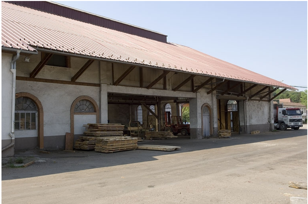
Façade nord de l'atelier de fabrication.
