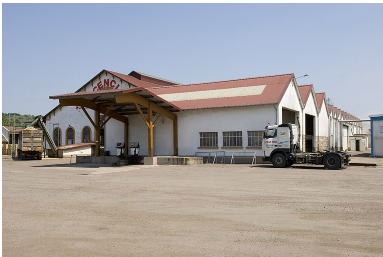
Ateliers de fabrication vus depuis le sud-ouest.
