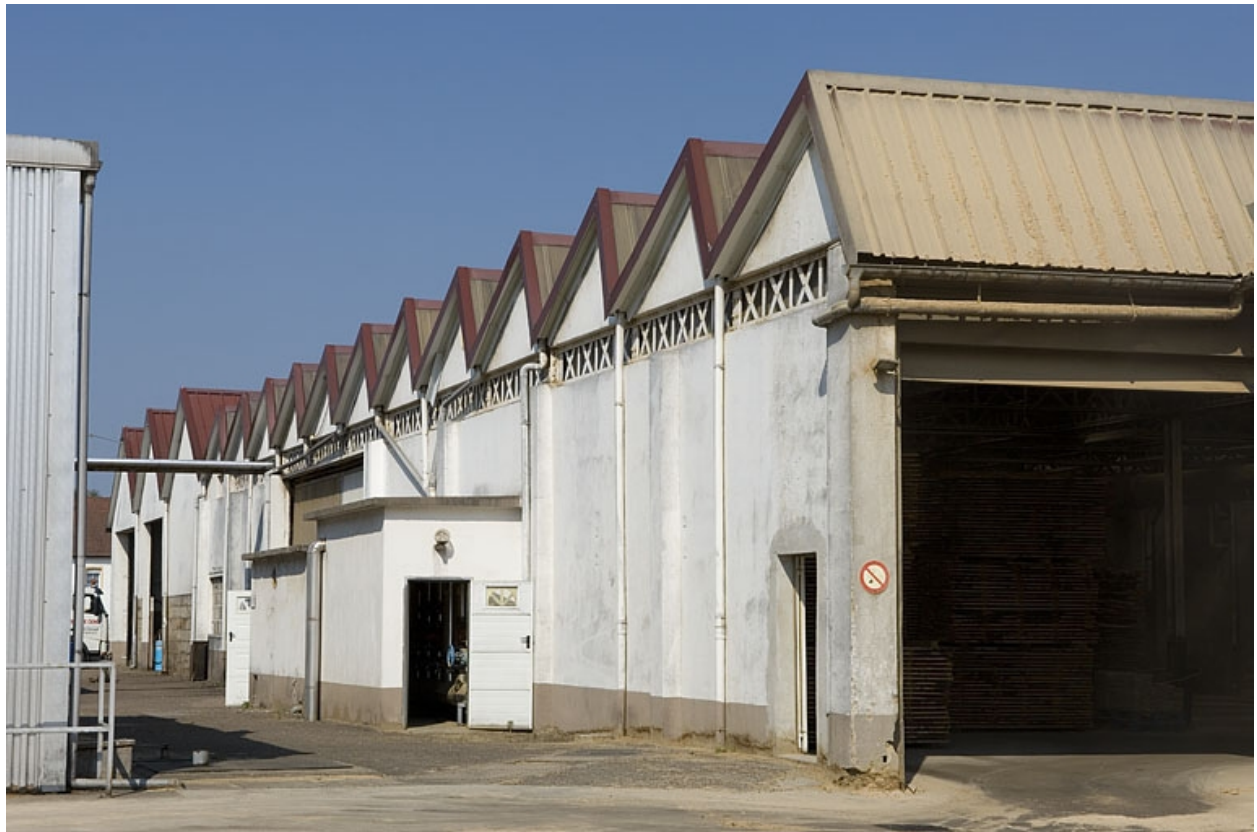
Extension sud couverte de sheds.
