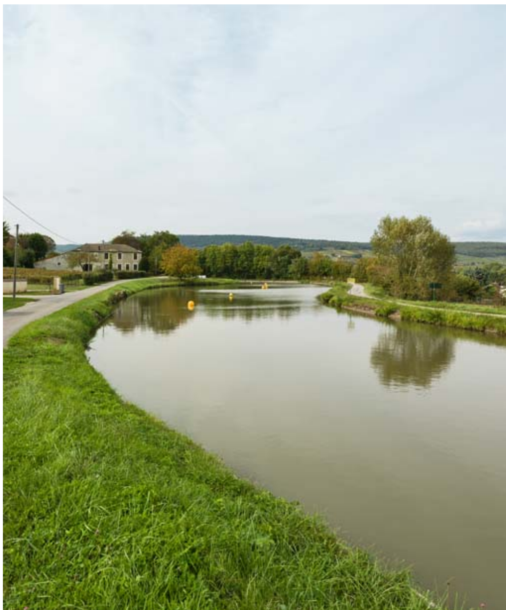
Vue d'ensemble du port.
