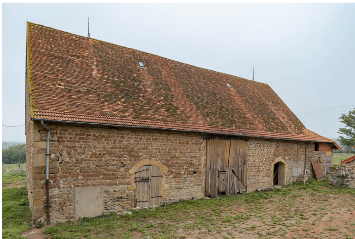
Façade antérieure de la grange
