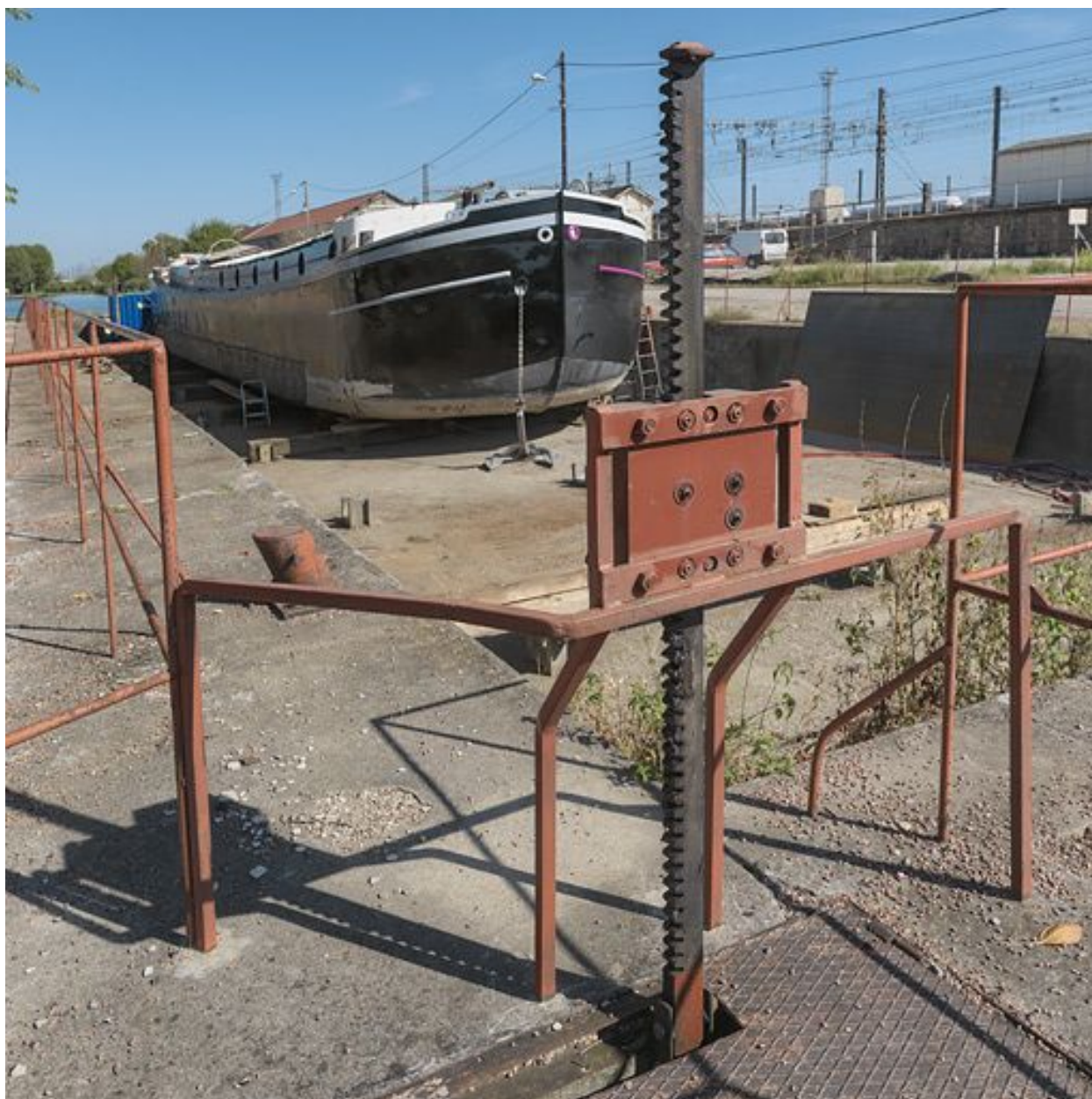
La cale sèche. Détail des vannes.
