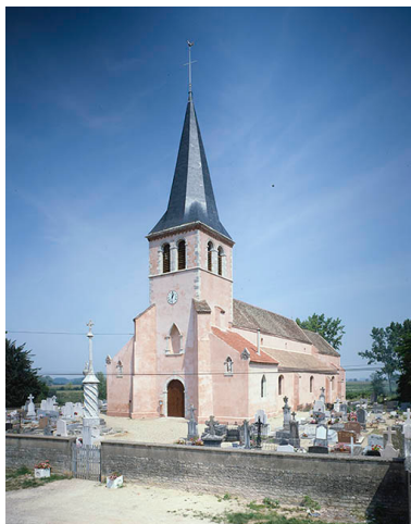
Vue d'ensemble. Phot. Michel Rosso IVR26_19882102794VA
