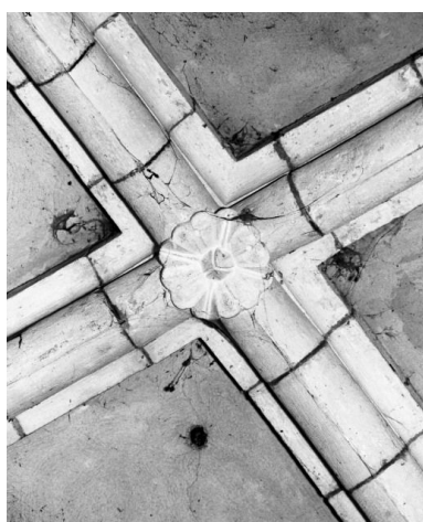
Choeur, 1ère travée, clef de voûte Phot. Jean-Luc Duthu IVR26_19852101766X
