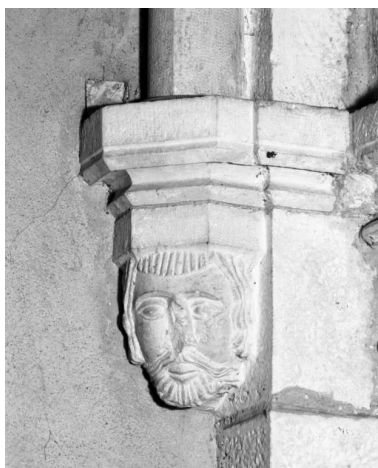
Chœur, 1ère travée, culot postérieur droit
