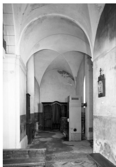
Pièce à droite du vestibule
