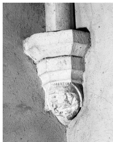
Chœur, 1ère travée, culot antérieur droit Phot. Jean-Luc Duthu IVR26_19852101756X
