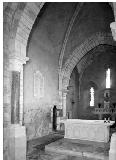
Choeur, mur gauche
