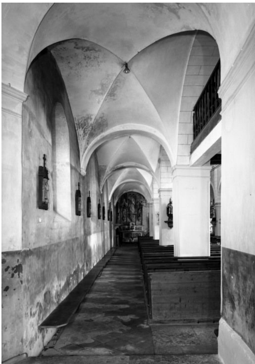
Bas-côté gauche, vue prise de l'entrée
