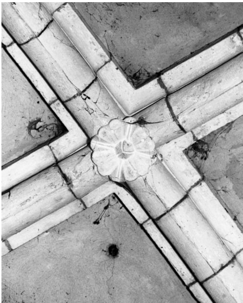
Choeur, 1ère travée, clef de voûte
