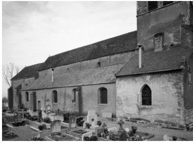
Elévation droite Phot. Michel Rosso IVR26_19852101735V
