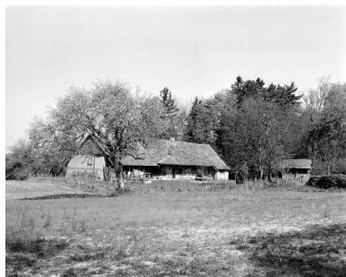
Vue générale. Phot. Bernard Lardière IVR43_19793900296X
