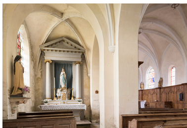
Vue intérieure de trois- quart du collatéral nord. Phot. Sonia Dourlot IVR43_20167001222NUC4A
