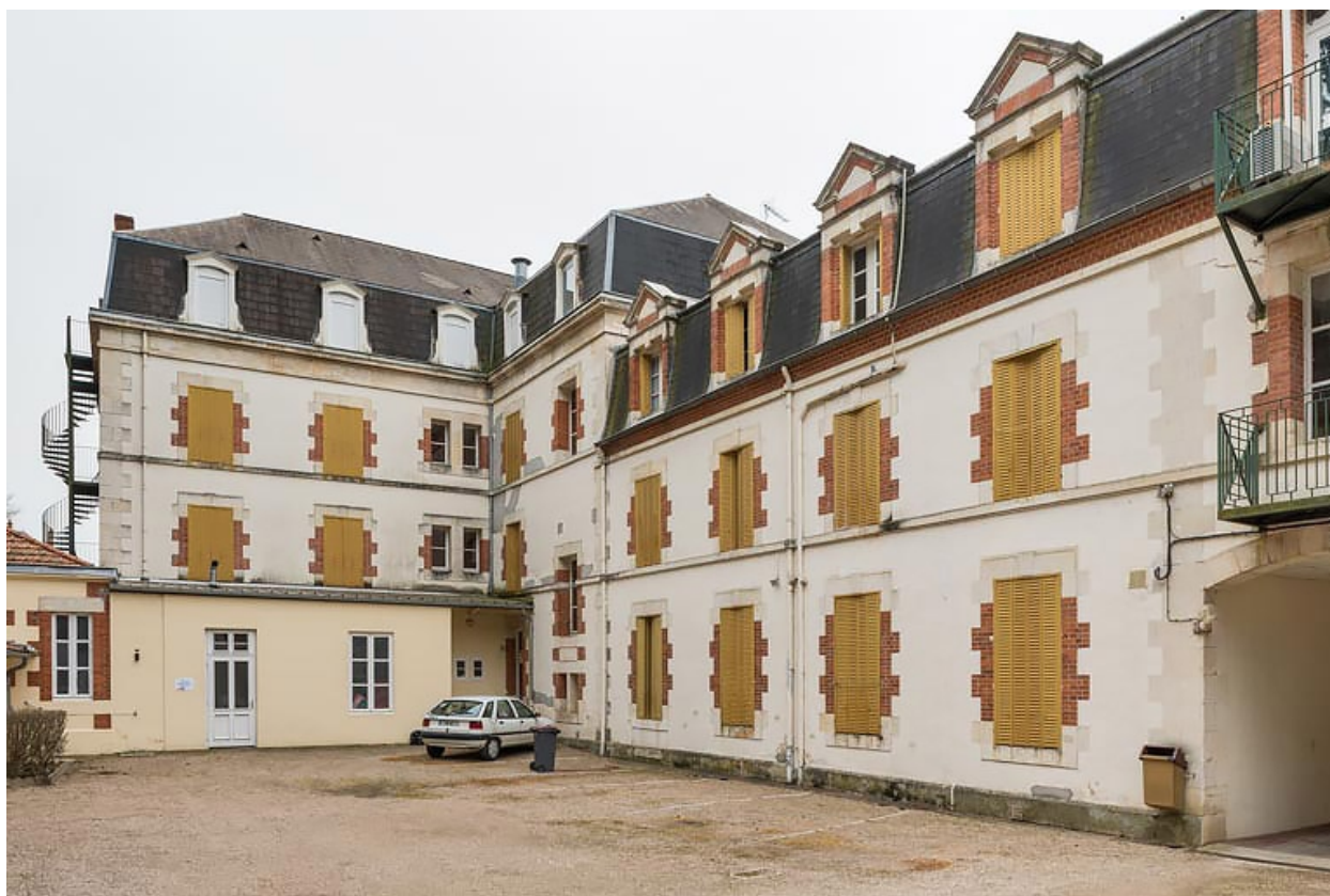
Façade sur la cour.
