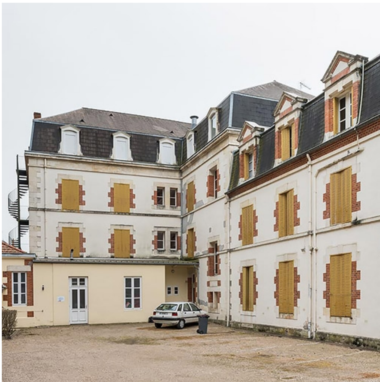
Façade sur la cour.
