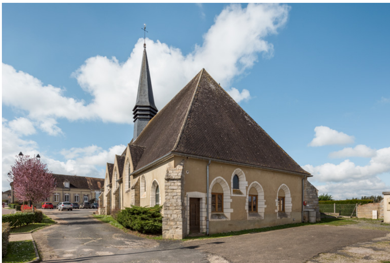
Vue de la sacristie (façade postérieure).
