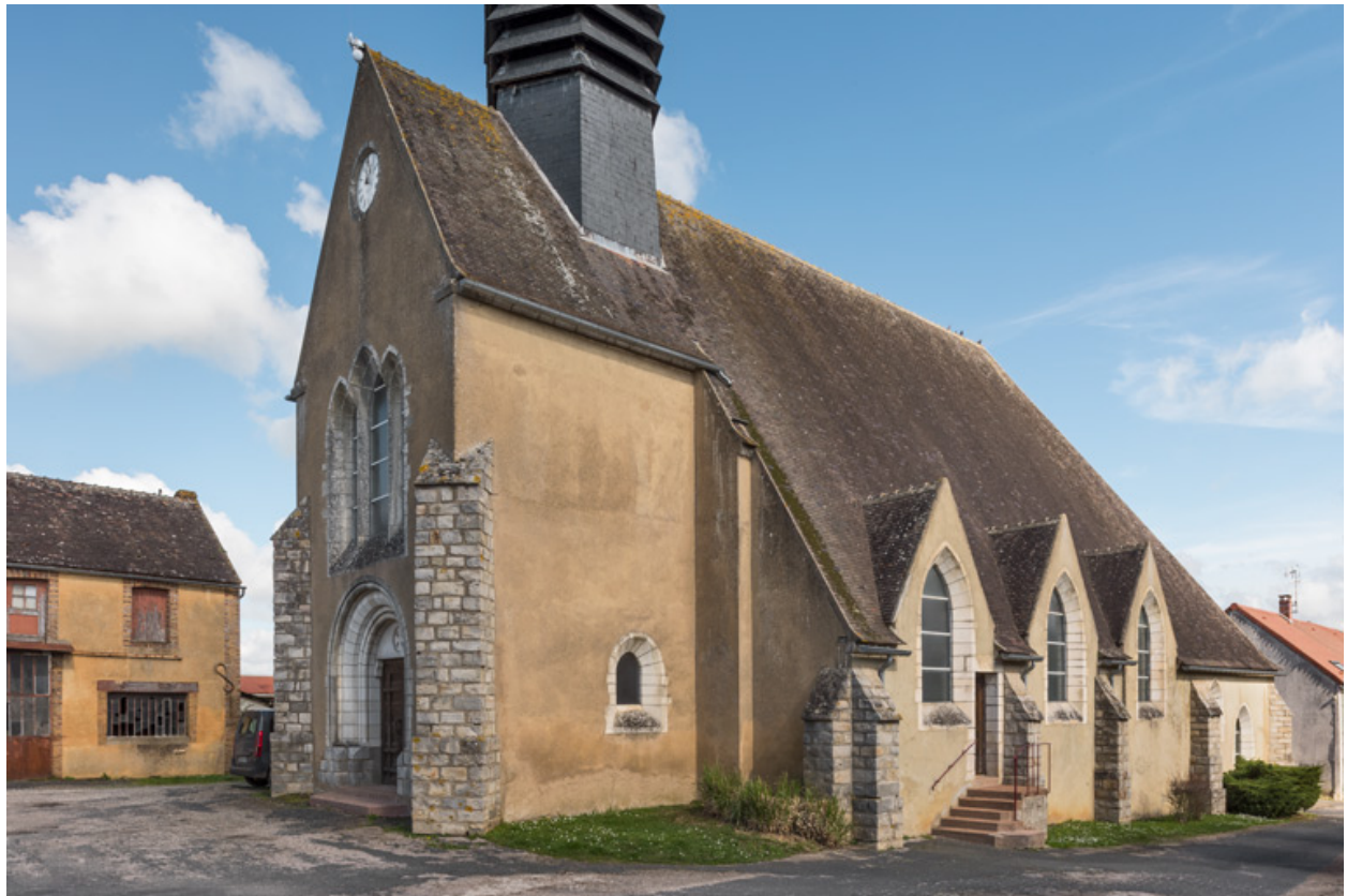
Vue des façades antérieure et droite.
