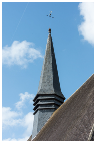
Détail du clocher. Phot. Pierre-Marie Barbe-Richaud IVR26_20248900091NUC4A
