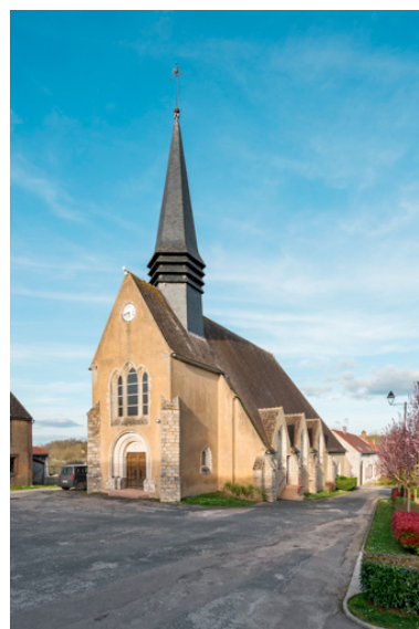
Vue d'ensemble de l'église. Phot. Pierre-Marie Barbe-Richaud IVR26_20248900085NUC4A
