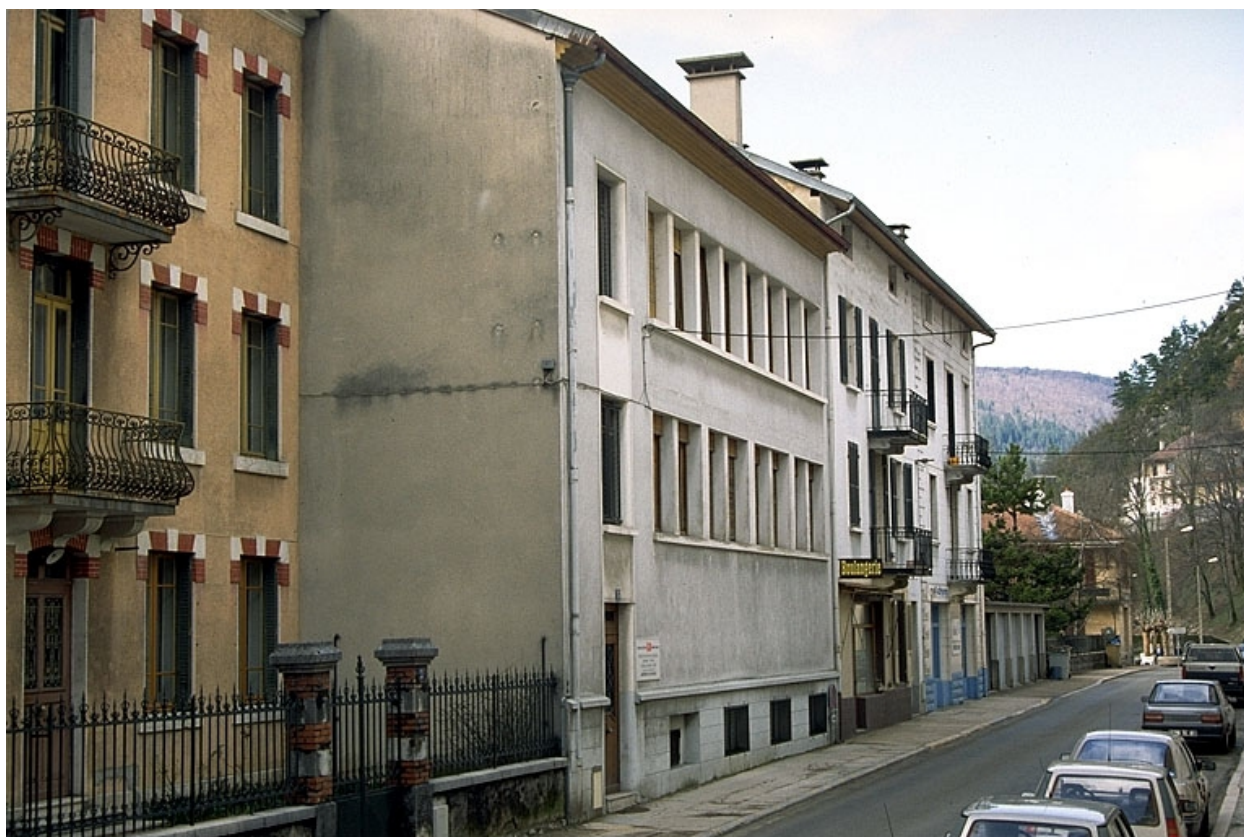
Vue d'ensemble, route de Genève.
