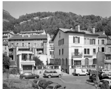
Façades sur la rue du Lieutenant Froidurot. Phot. Jérôme Mongreville IVR43_19923900772X
