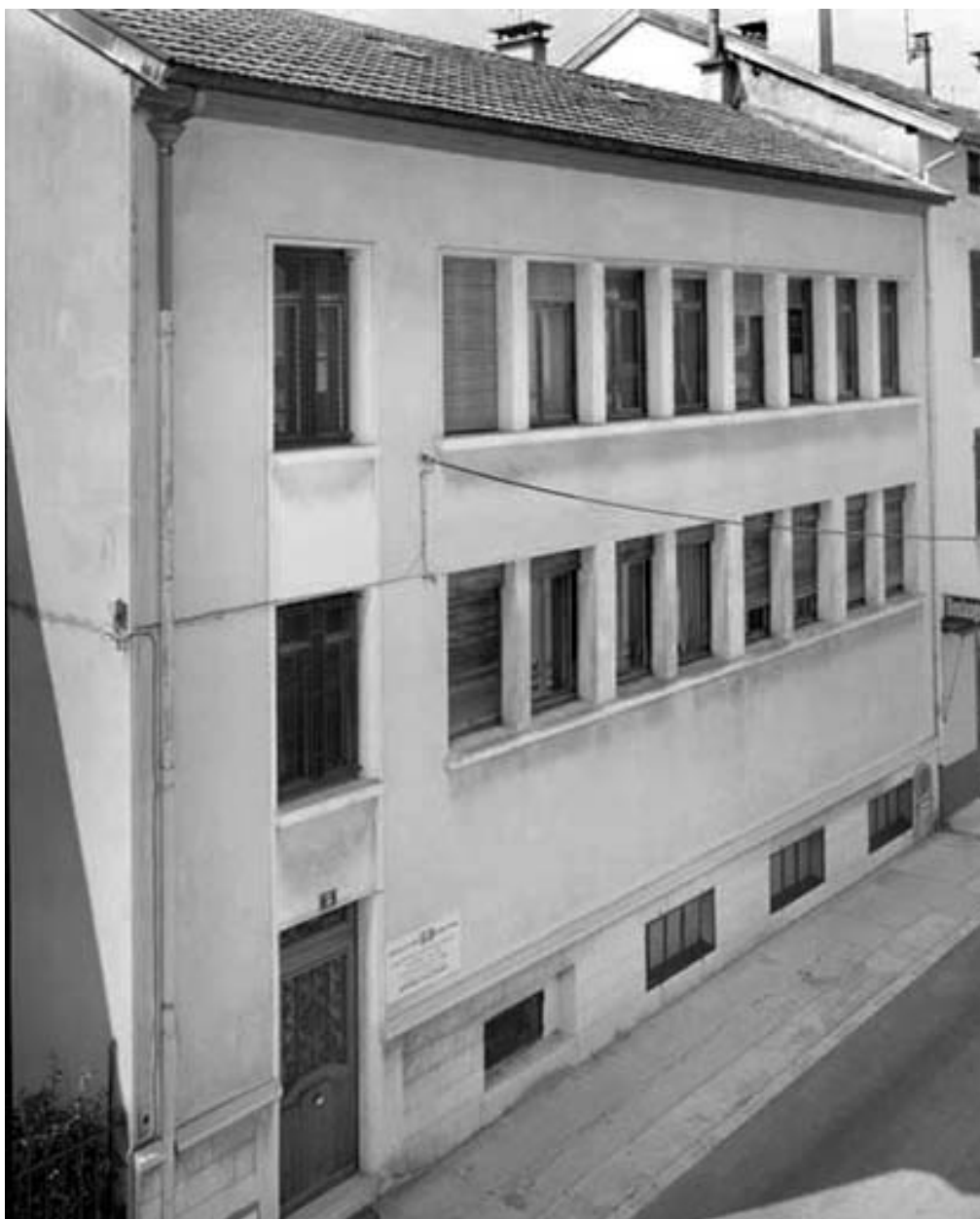
Façade antérieure, route de Genève.
