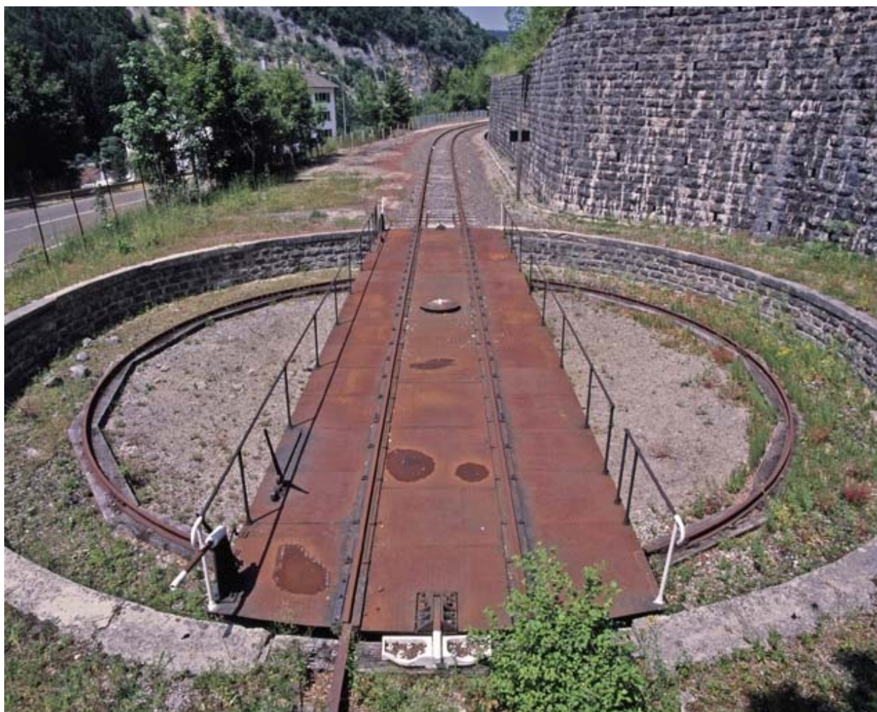
Tablier, fosse et chemin de roulement.
