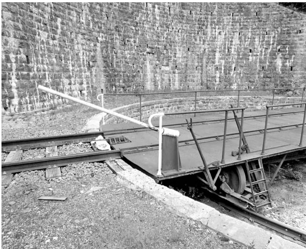
Barre permettant de faire pivoter le pont.
