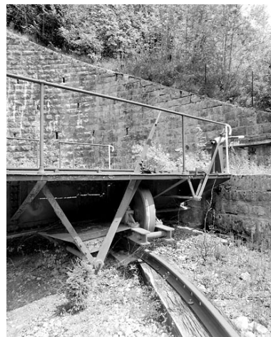
Système de roulement et leviers de blocage. Phot. Yves Sancey IVR43_20033900967X
