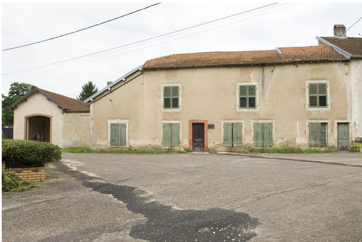
Vue du bâtiment d'entrée.
