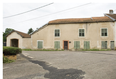
Vue du bâtiment d'entrée. Phot. Jérôme Mongreville IVR43_200970000816NUC2A
