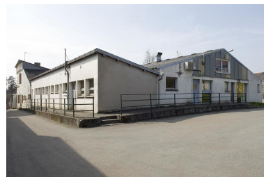
Vestiaires, bureau et atelier d'usinage. Phot. Jérôme Mongreville IVR43_20097000301NUC2A
