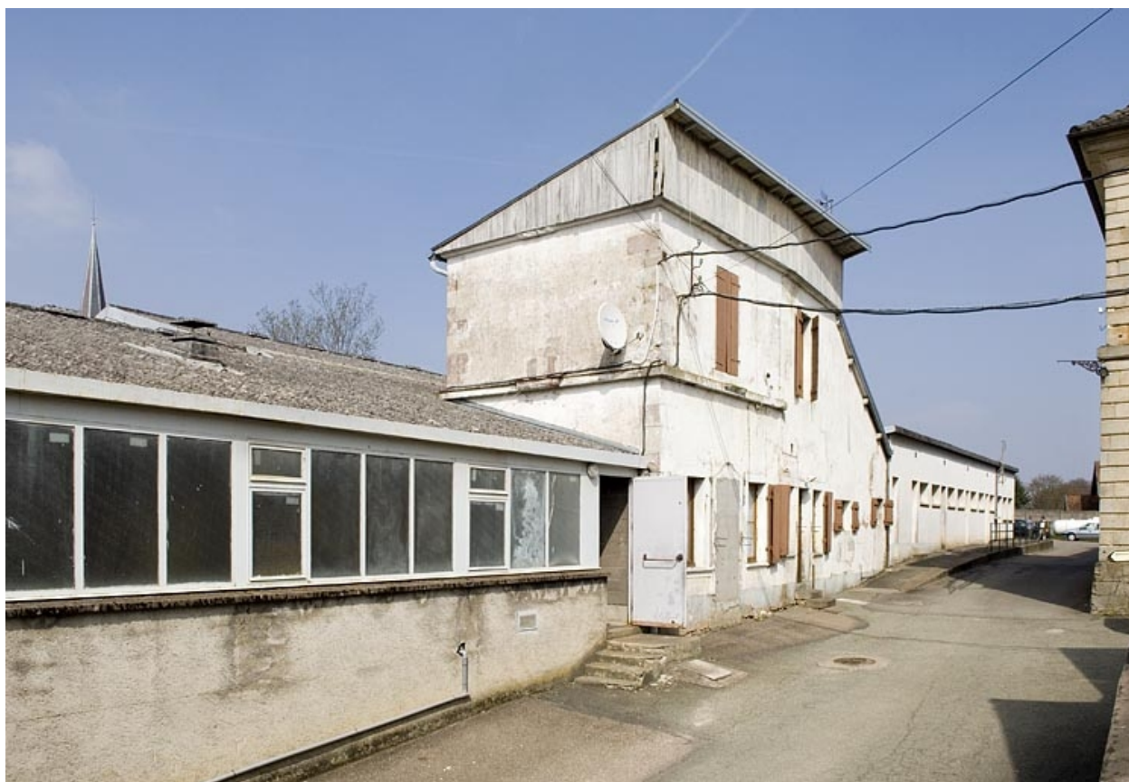
Atelier et logement.
