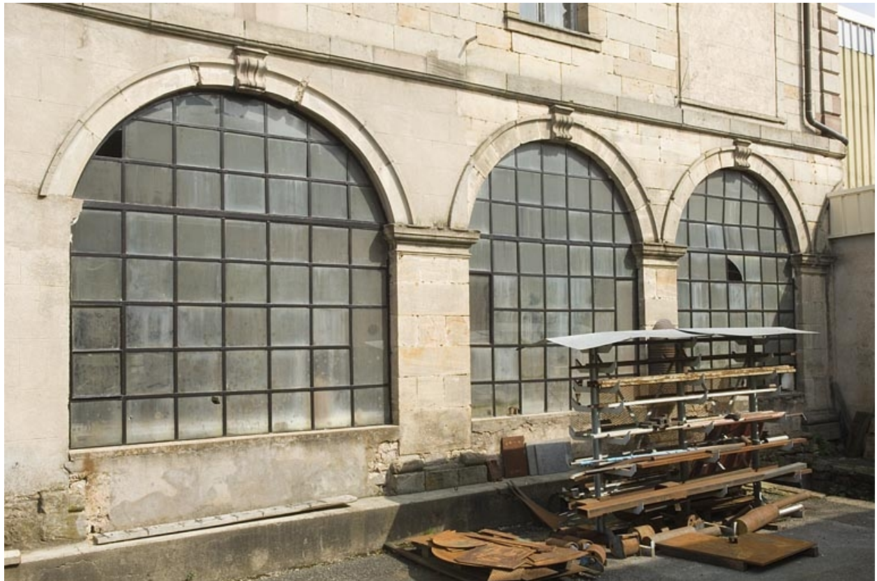
Bâtiment prieural. Baies de la façade ouest.
